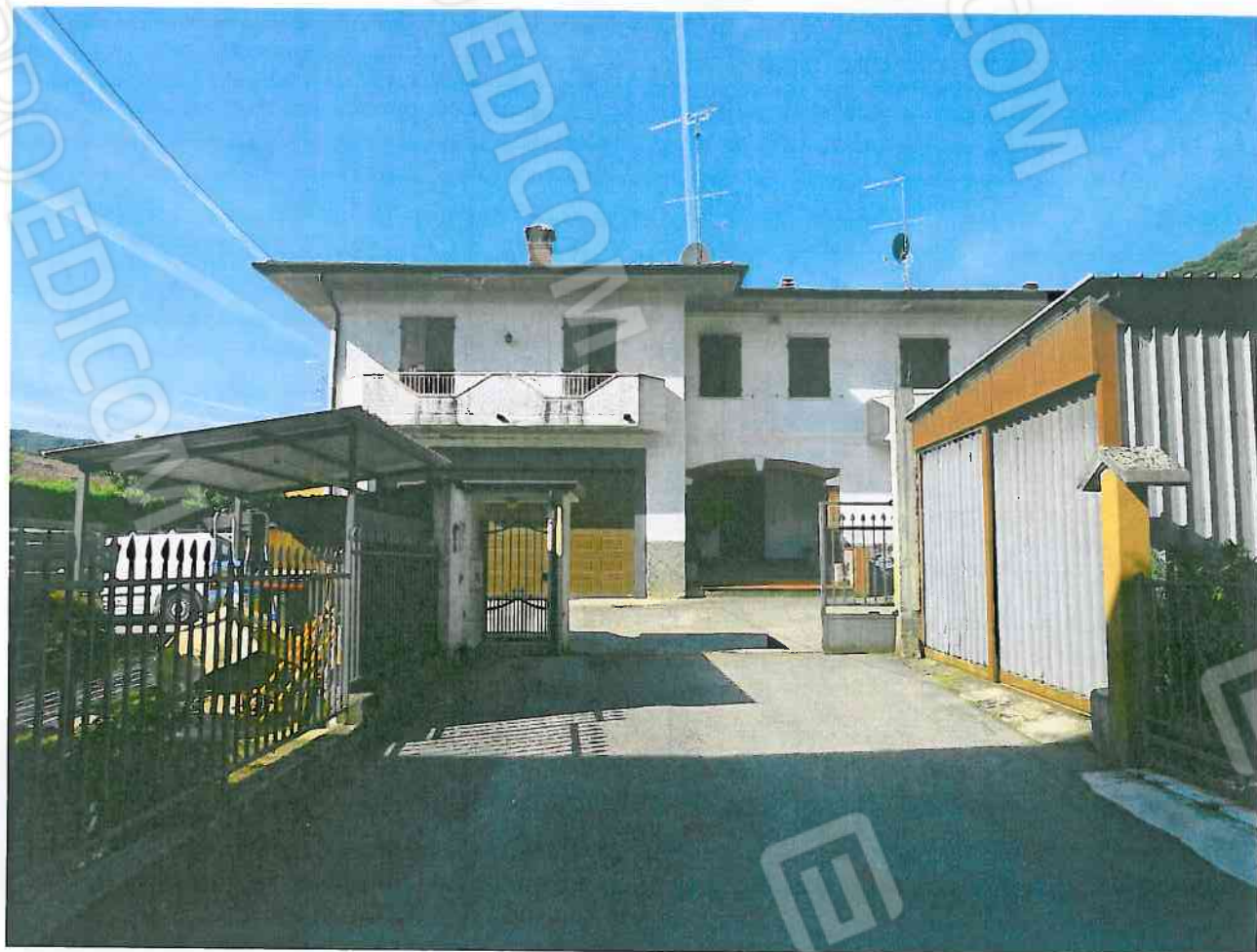
L'accesso al bene esecutato visibile sullo sfondo
