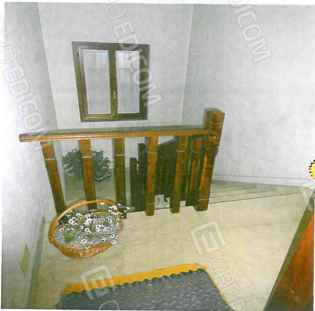
Il vano scala interno comune con altra proprietà
