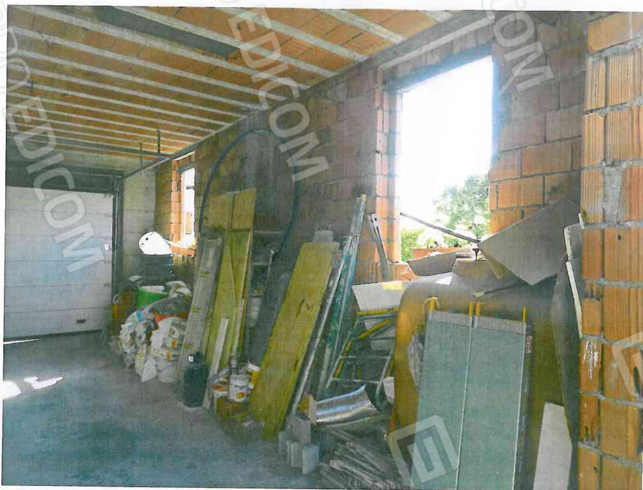
Il lato interno Est del locale uso magazzino
