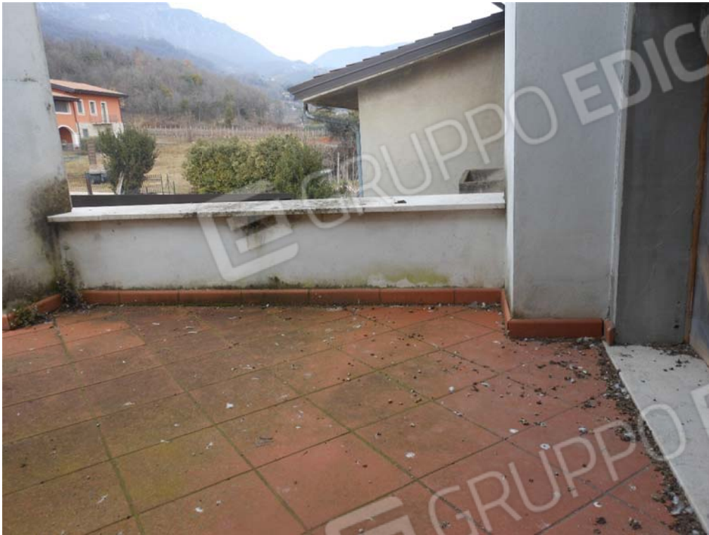
Foto 29: terrazza piano primo
