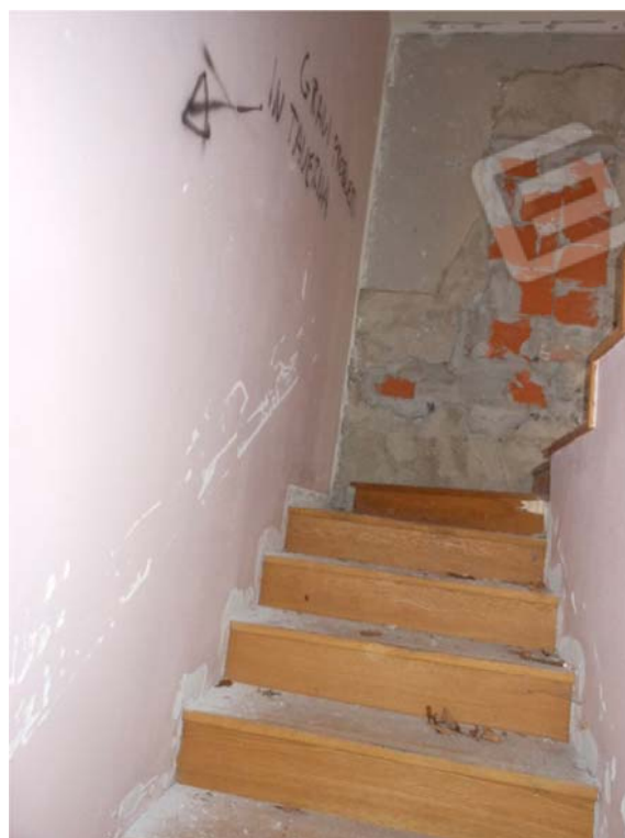
Foto 17: Scala piano interrato
