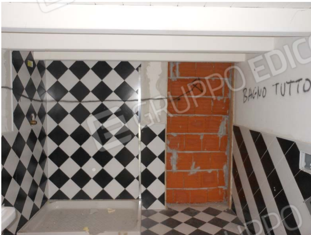
Foto 31: Porta accesso sub.47 murata
