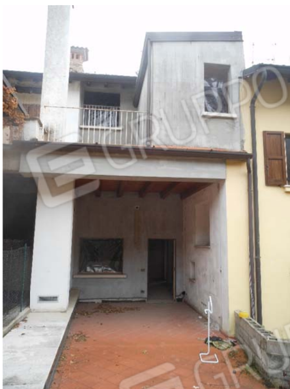
Foto 12: Prospetto lato ovest
