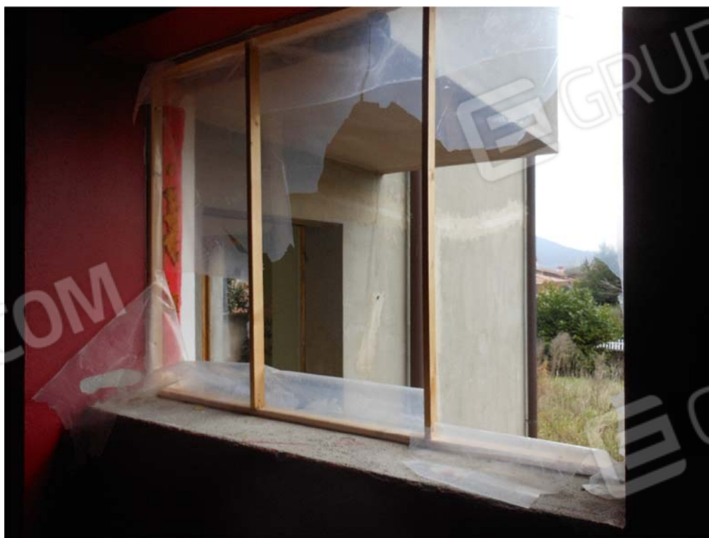
Foto 15: Particolare serramenti rimossi bagno piano terra
