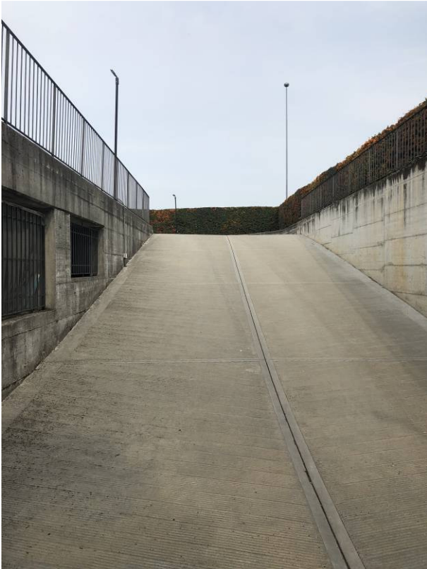
Vista della rampa carraia di accesso ai posti auto interrati
