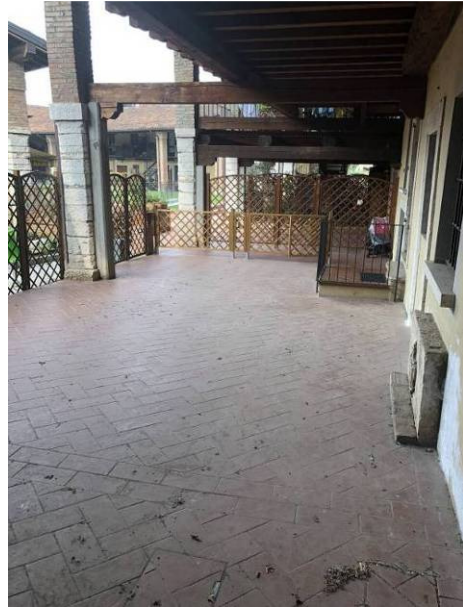
Vista interna del porticato
