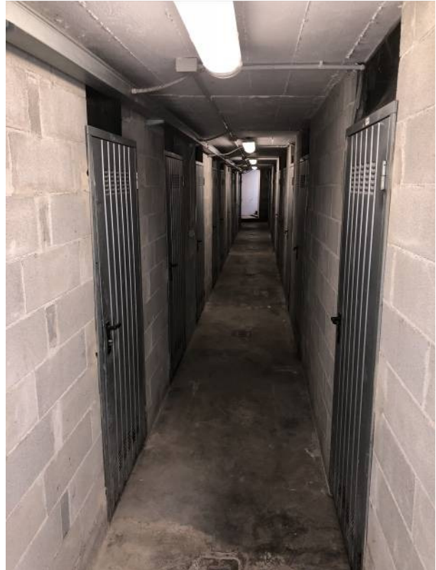
Vista del corridoio di accesso alle cantine
