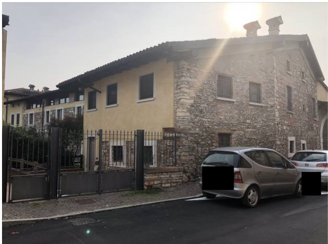
Vista dell'unità immobiliare da via Monte Pasubio
