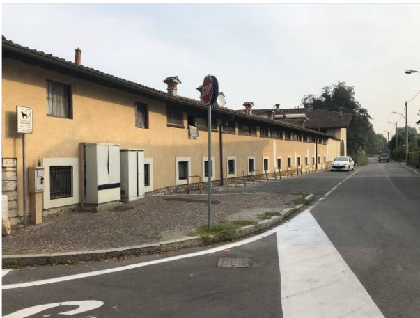
Vista dell'unità immobiliare da via Risorgimento
