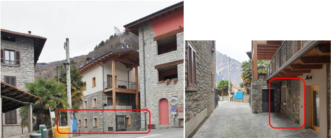
FOTO 16/17: vista del fabbricato dalla Via Breda, lato ovest e sud. Vista del fronte sud dal cortile interno
