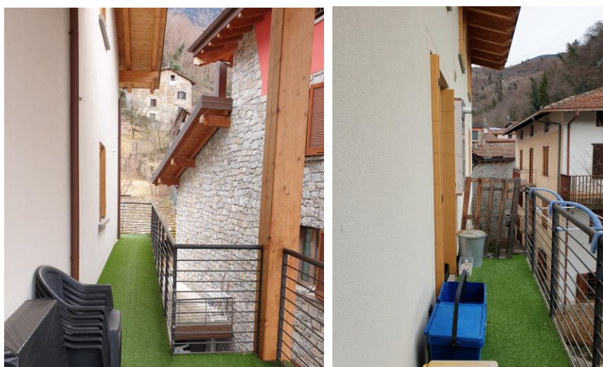
FOTO 46/47: portico e balcone di uso esclusivo a lato sud e a lato est.
