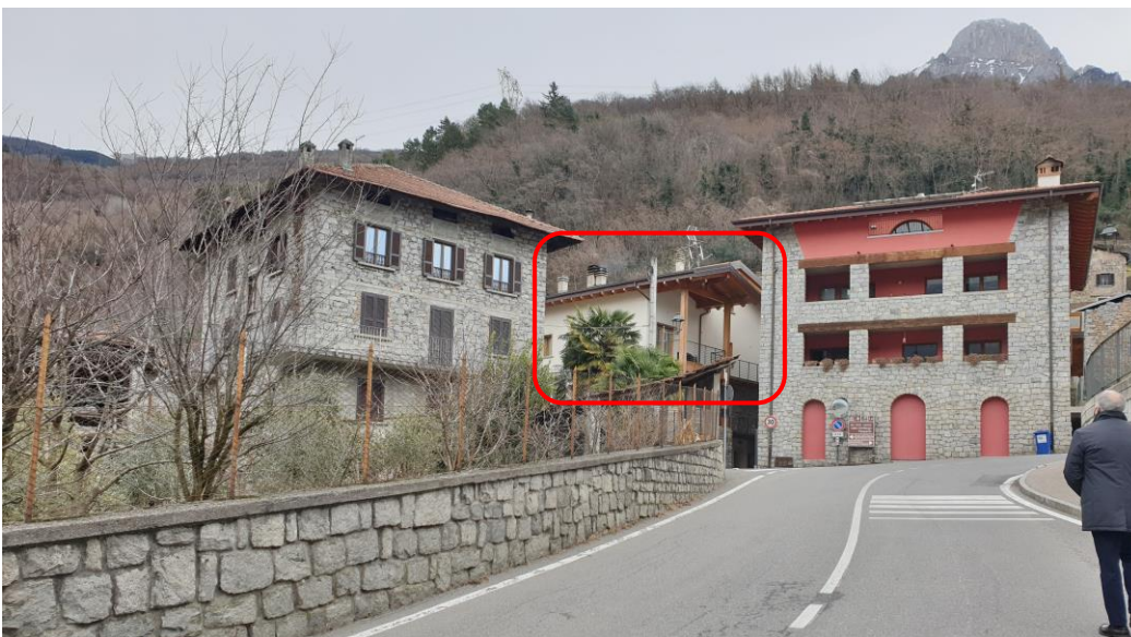
FOTO 32: vista del fabbricato dalla Via Breda, lato ovest e sud. Vista del portico sud, dal cortile interno.
