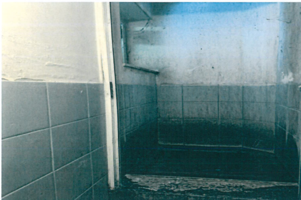
CADITOIA dim. 1,00x1,00 NEL GIARDINO: CHE DANNEGGIA ZONA NELL'INTERRATO
