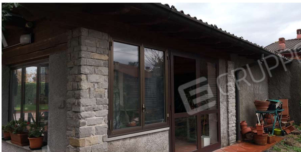
Fig. 41 – Vista esterna (lato Est) del ripostiglio/locale pompe.
