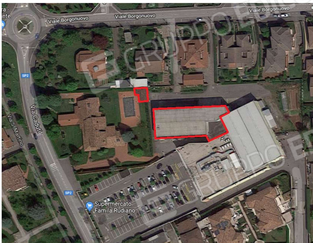
Fig. 1 – Inquadramento generale dell'unità immobiliare oggetto della presente.
