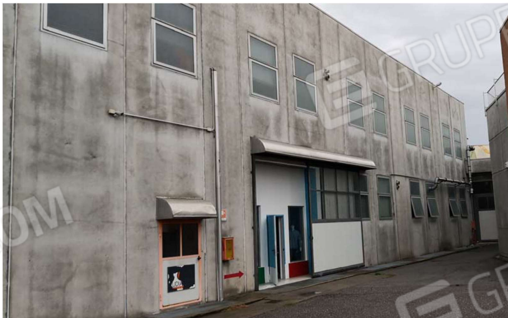
Fig. 8 – Vista esterna – lato Sud - dell'unità immobiliare oggetto della presente.
