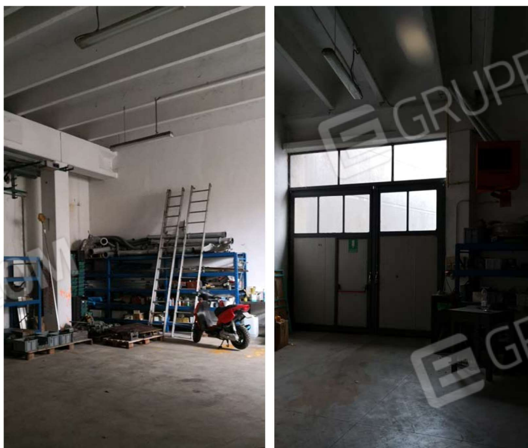
Fig. 30 – Vista interna del portico convertito a magazzino al piano terra sul lato Sud/Est dell'immobile.
