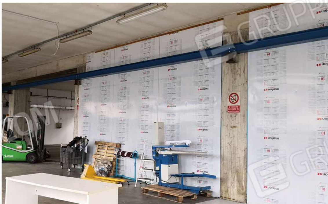
Fig. 26 – Delimitazione al piano terra dello spazio convertito a zona di vendita abbigliamento.
