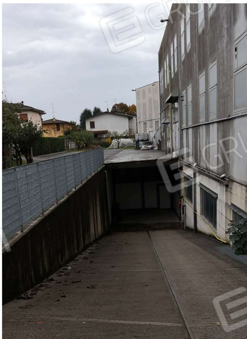
Fig. 13 – Vista esterna del corsello che consente di raggiungere il piano interrato.
