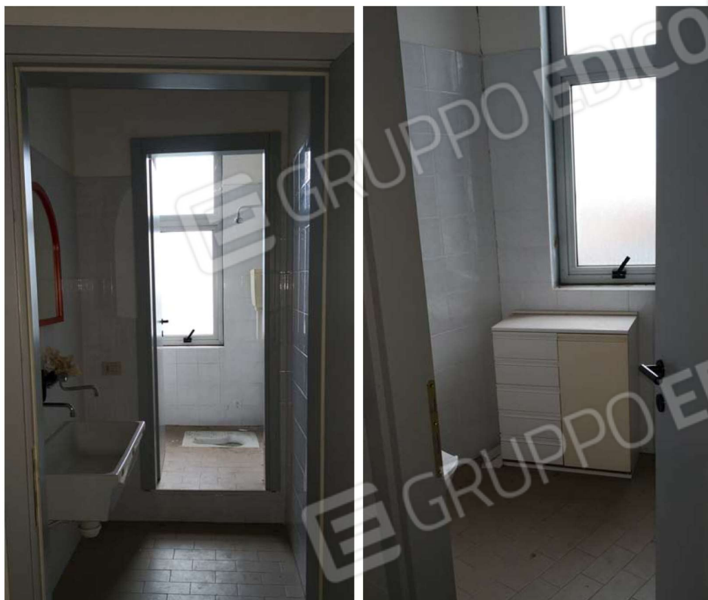
Fig. 38 – Vista interna di alcuni bagni presenti al piano terra sul lato Est dell'immobile.
