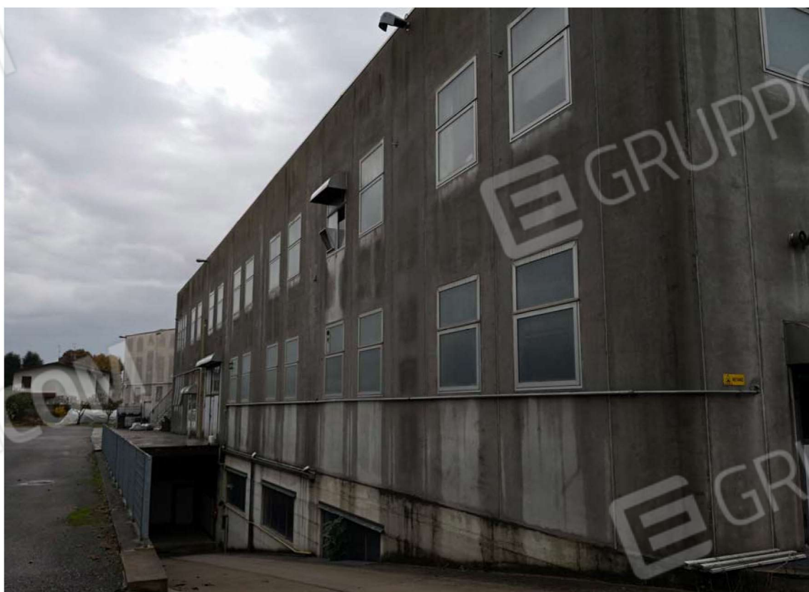
Fig. 6 – Vista esterna – lato Nord - dell'unità immobiliare oggetto della presente.
