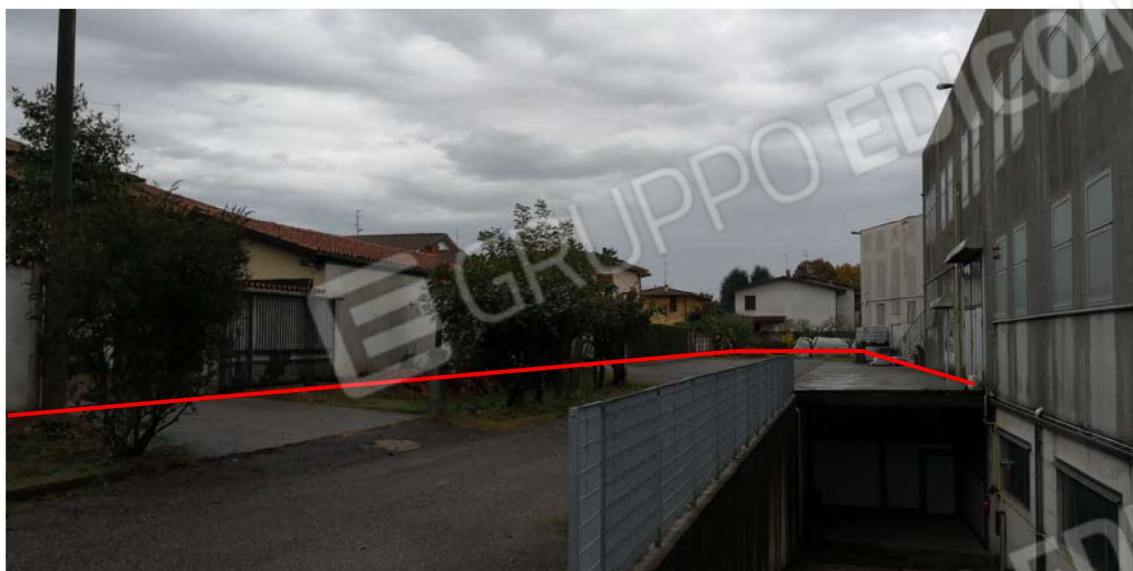
Fig. 12 – Vista cortile interno posto sul lato Nord, oggetto della presente.
