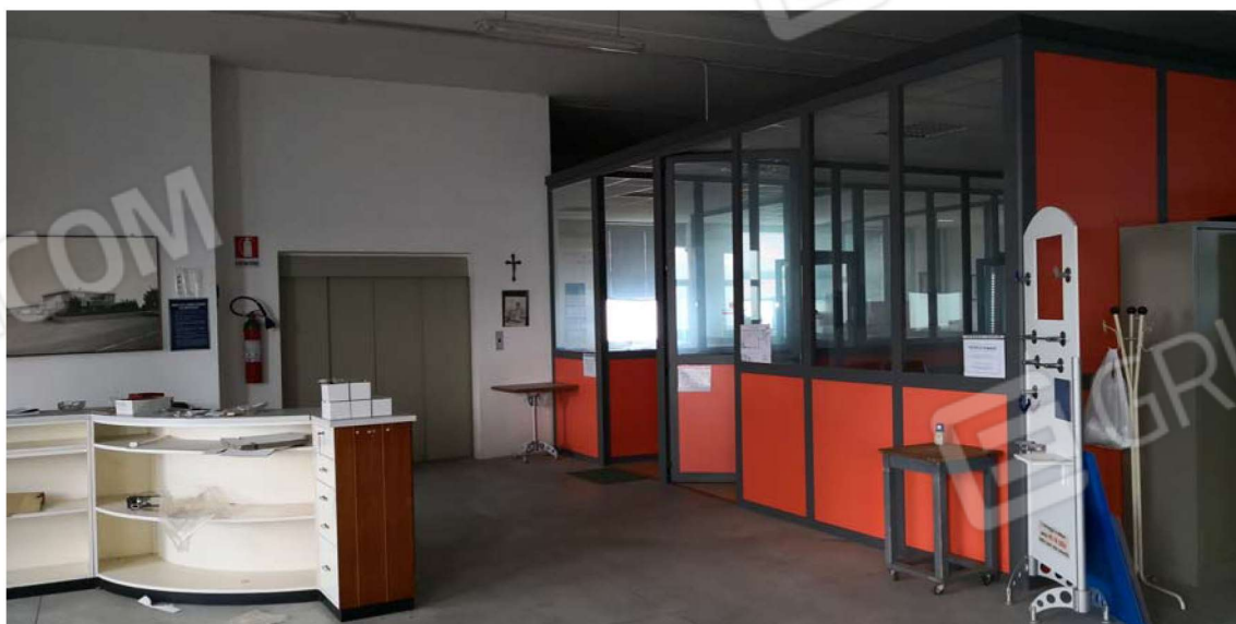
Fig. 35 – Vista interna del piano primo (zona uffici). Nell'immagine si può vedere il montacarichi che consente di collegare il piano primo con il piano interrato.
