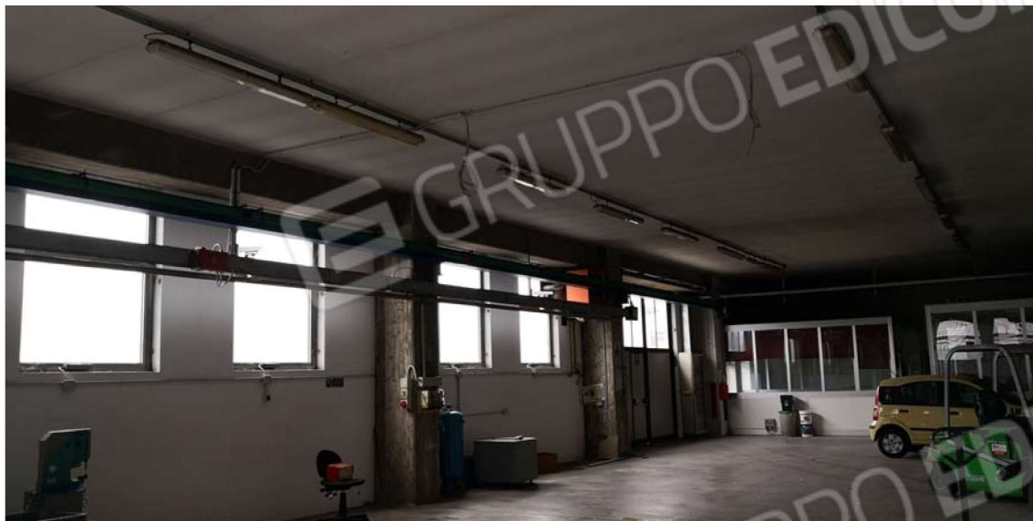
Fig. 23 – Vista interna del piano terra (ex zona lavorazione/produzione).
