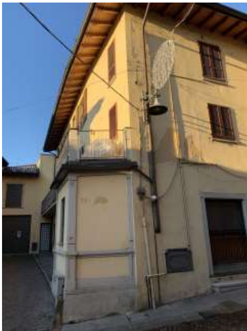
Vista del fabbricato da Via Gorini
