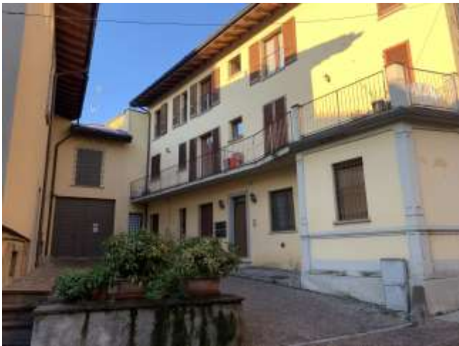
Accesso al fabbricato dalla corte antistante da via Gorini
