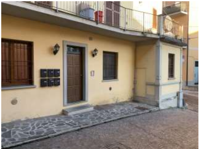
Ingresso vano scale condominiale al civico n°25
