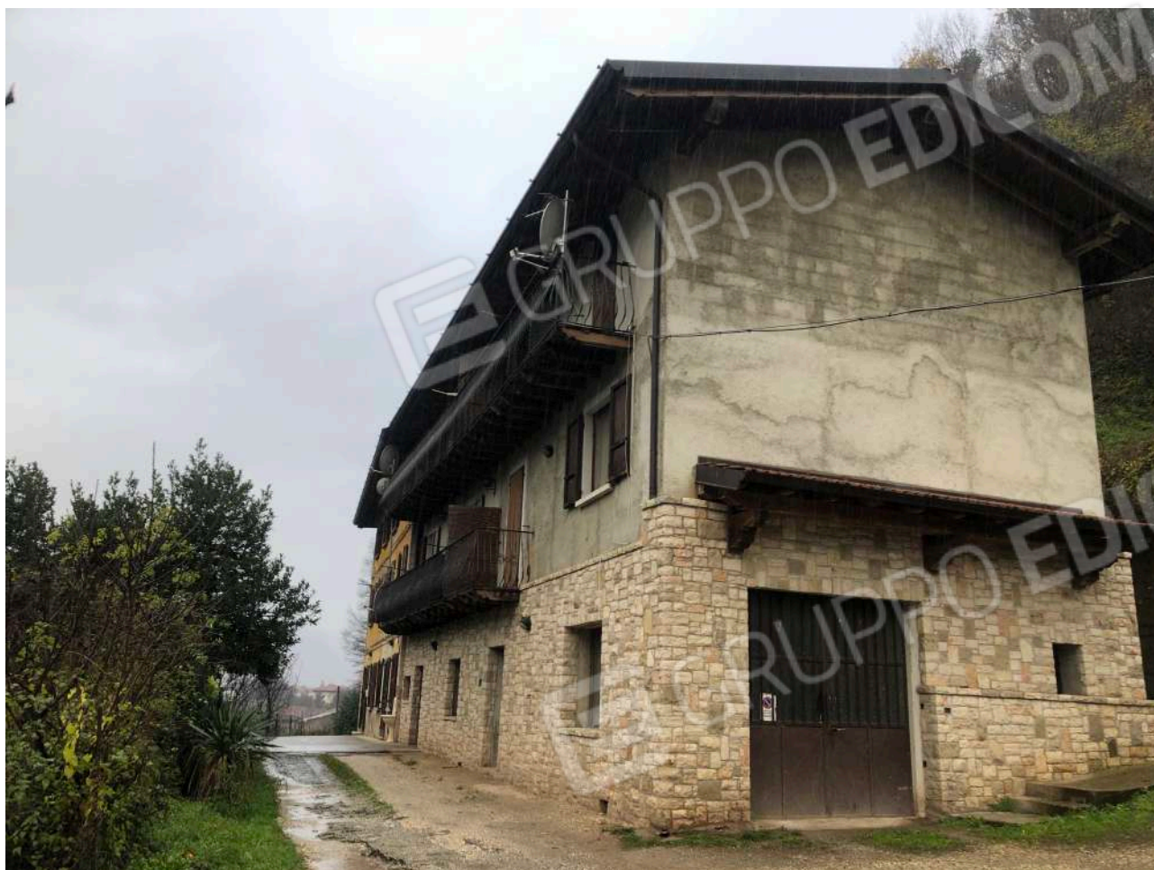
Foto n°3: Vista esterna del fronte nord del fabbricato
