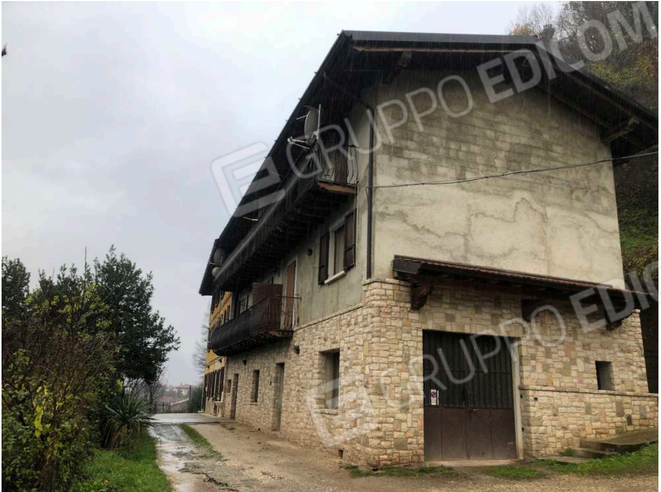
Foto n°1: Vista esterna del fronte nord del fabbricato
