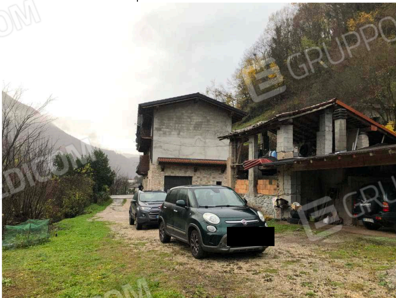
Foto n°14: Spazio antistante il fabbricato sul fronte nord
