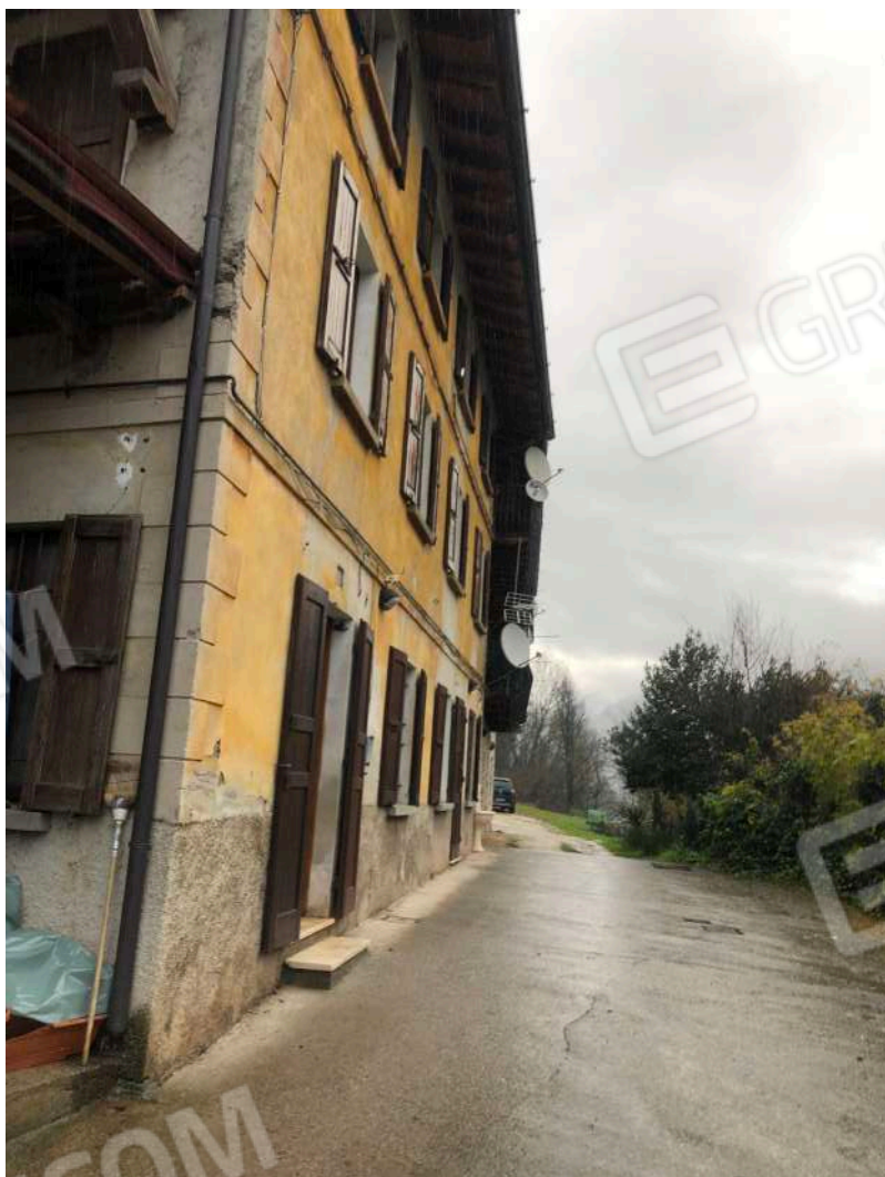
Foto n°2: Vista esterna del fronte sud-est del fabbricato
