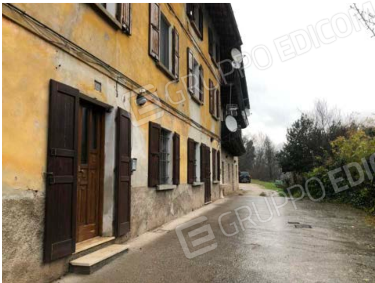
Foto n°1: Vista esterna del fronte est del fabbricato
