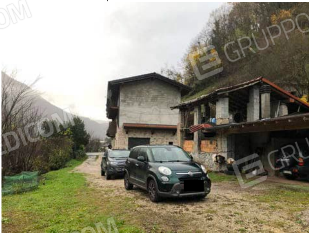
Foto n°38: Spazio antistante il fabbricato sul fronte nord
