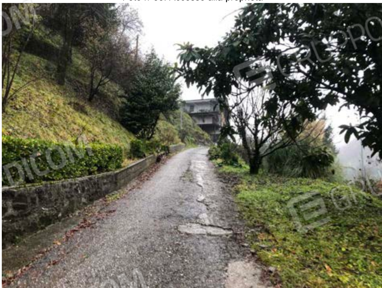
Foto n°34: Strada d'accesso alla proprietà
