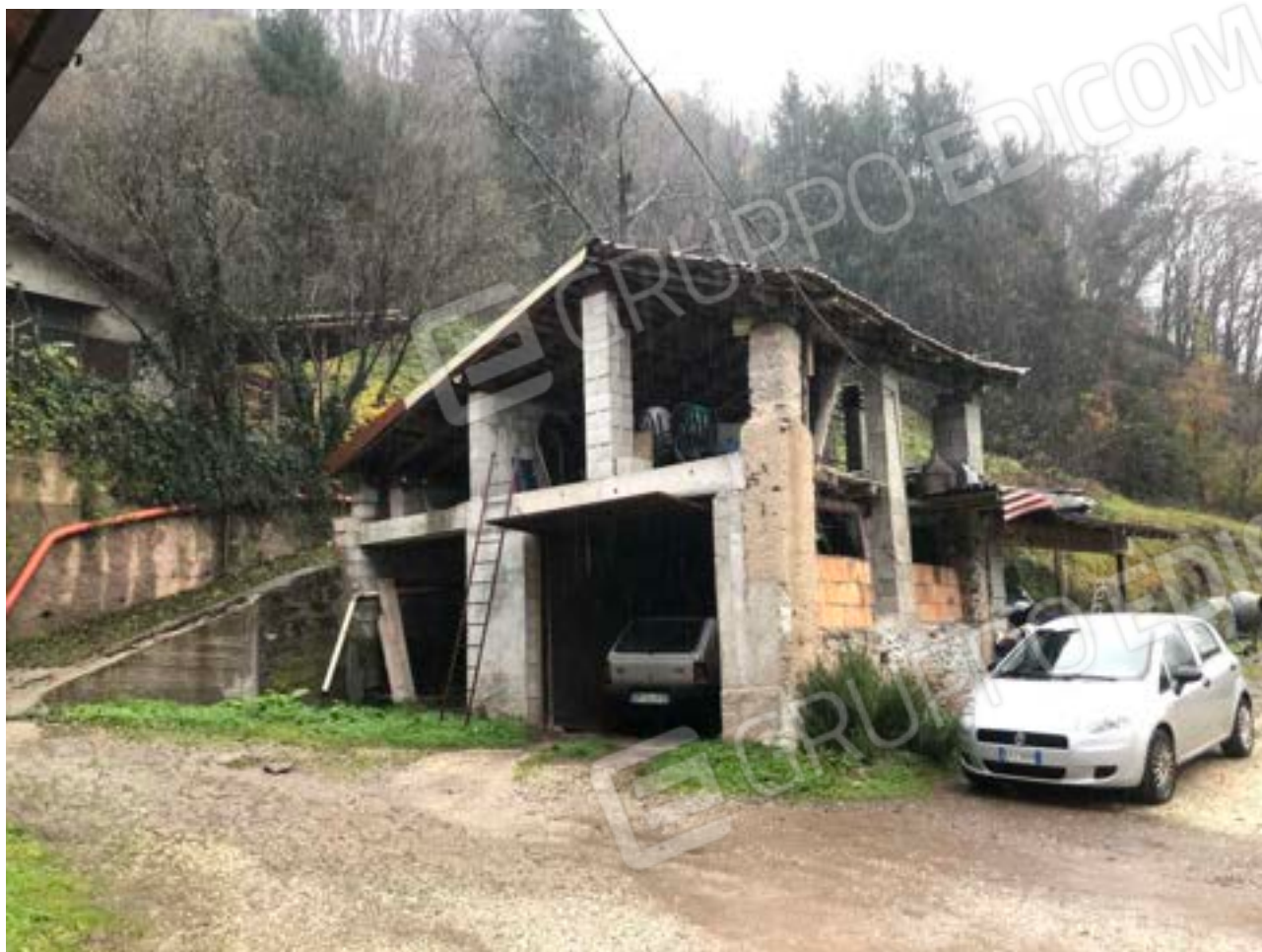
Foto n°19: Corpo di fabbrica n°1 con locali accessori (sub.4)
