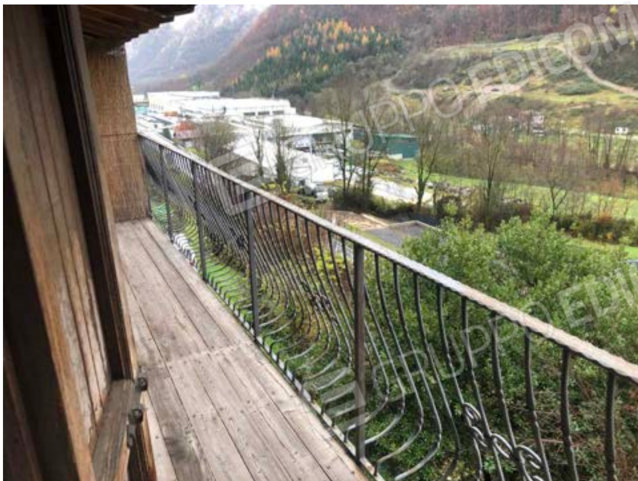
Foto n°7: Balcone posto sul fronte est
