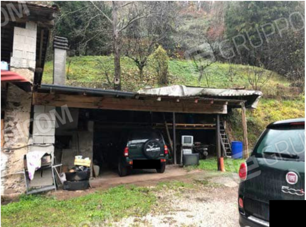
Foto n°26: Corpo di fabbrica n°1 con locali accessori (sub.4)
