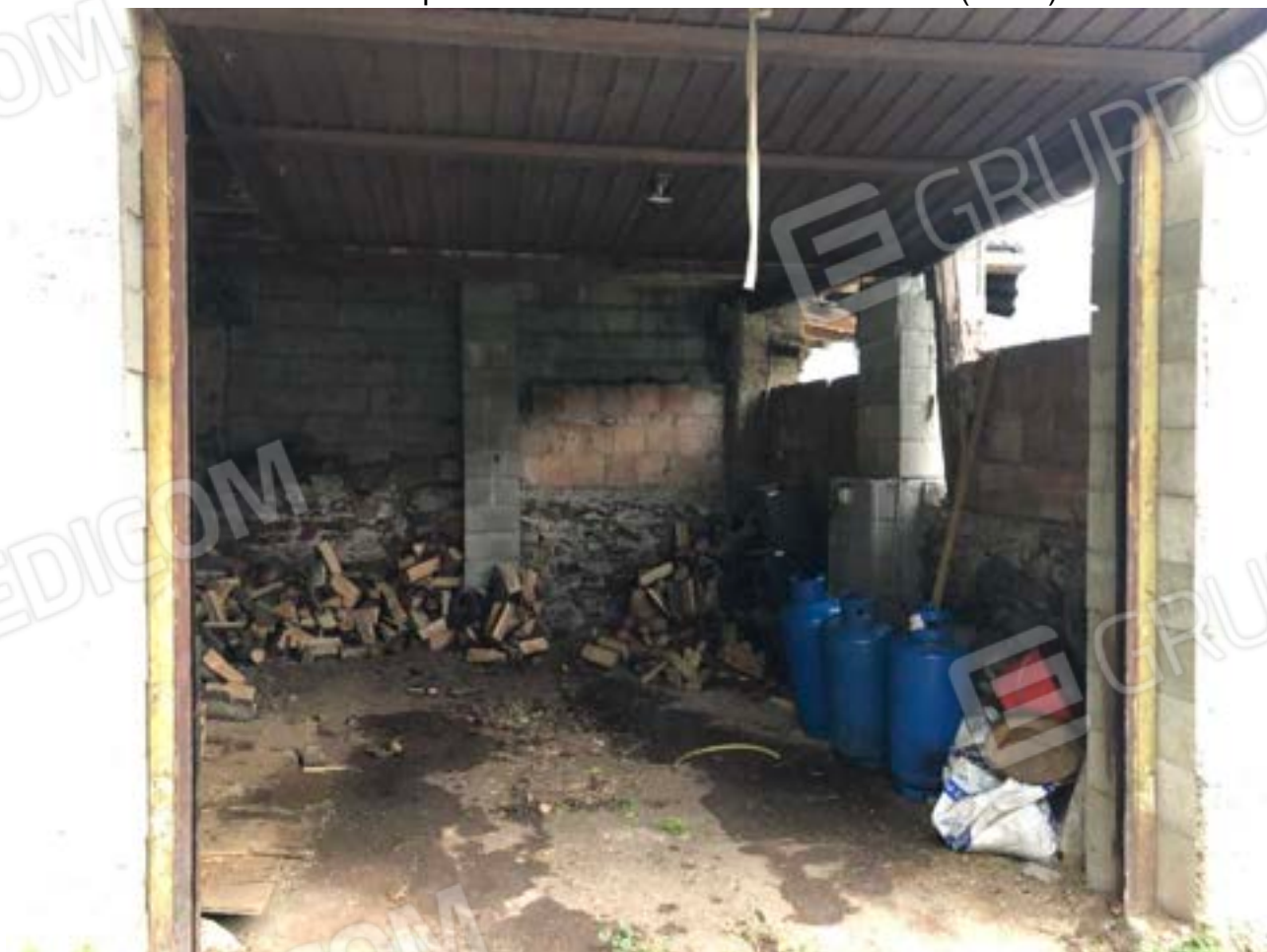
Foto n°22: Corpo di fabbrica n°1 con locali accessori (sub.4)
