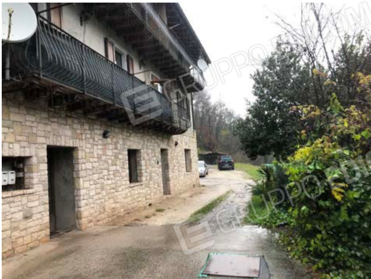
Foto n°37: Spazio antistante il fabbricato sul fronte est
