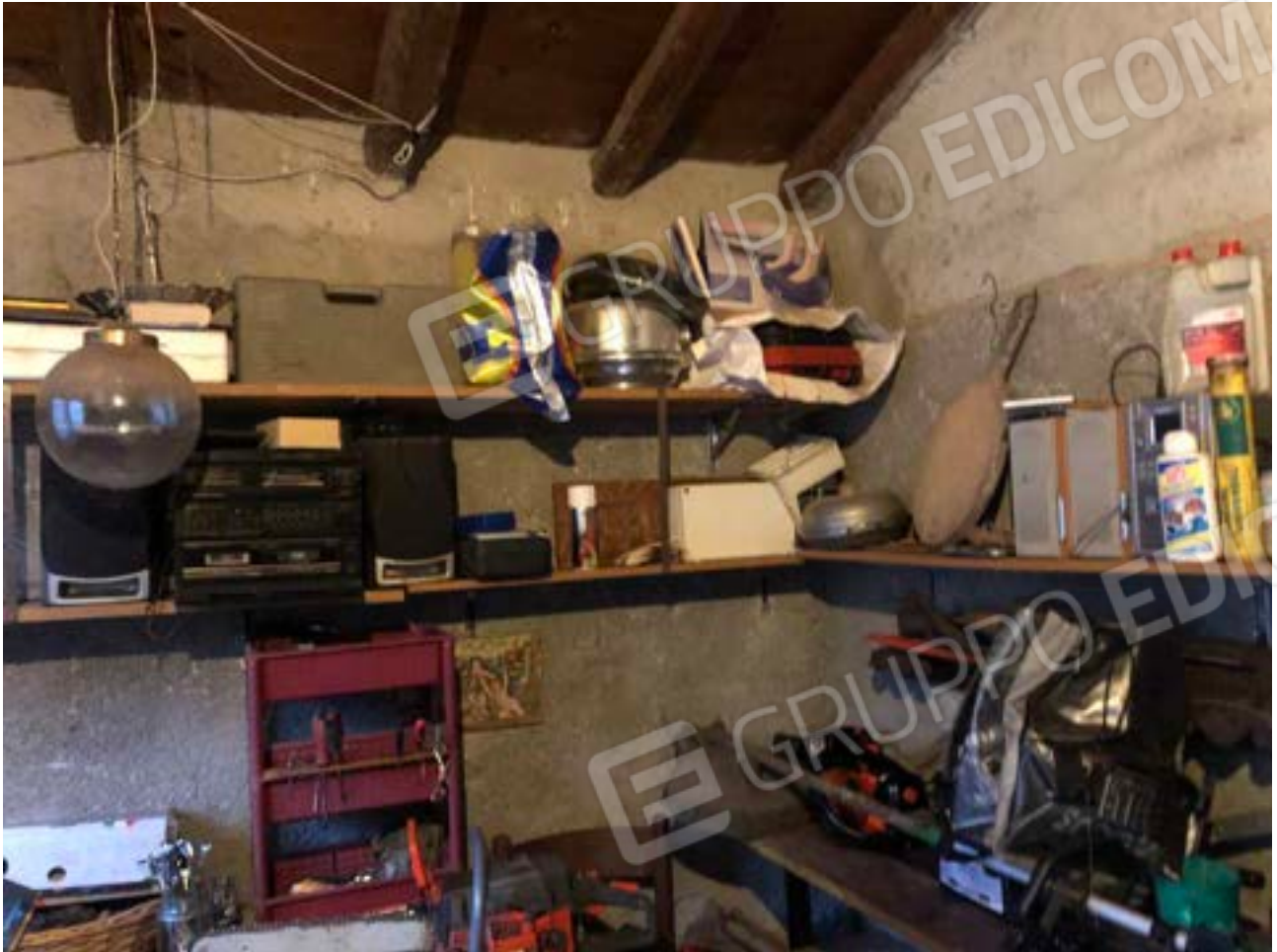
Foto n°29: Corpo di fabbrica n°2 con locali accessori (sub.5)
