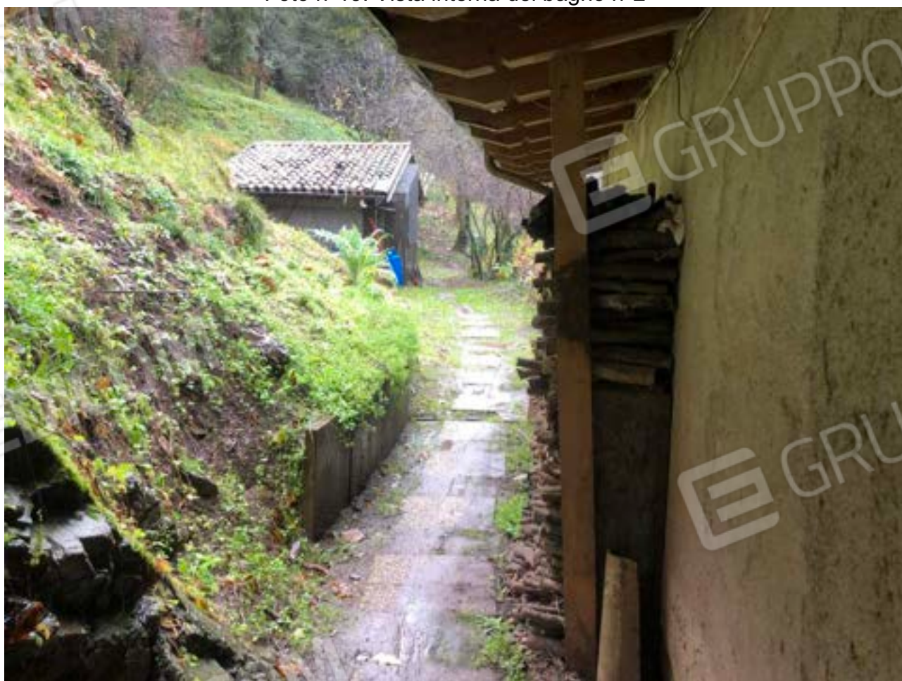
Foto n°16: Spazio antistante il fabbricato sul fronte ovest
