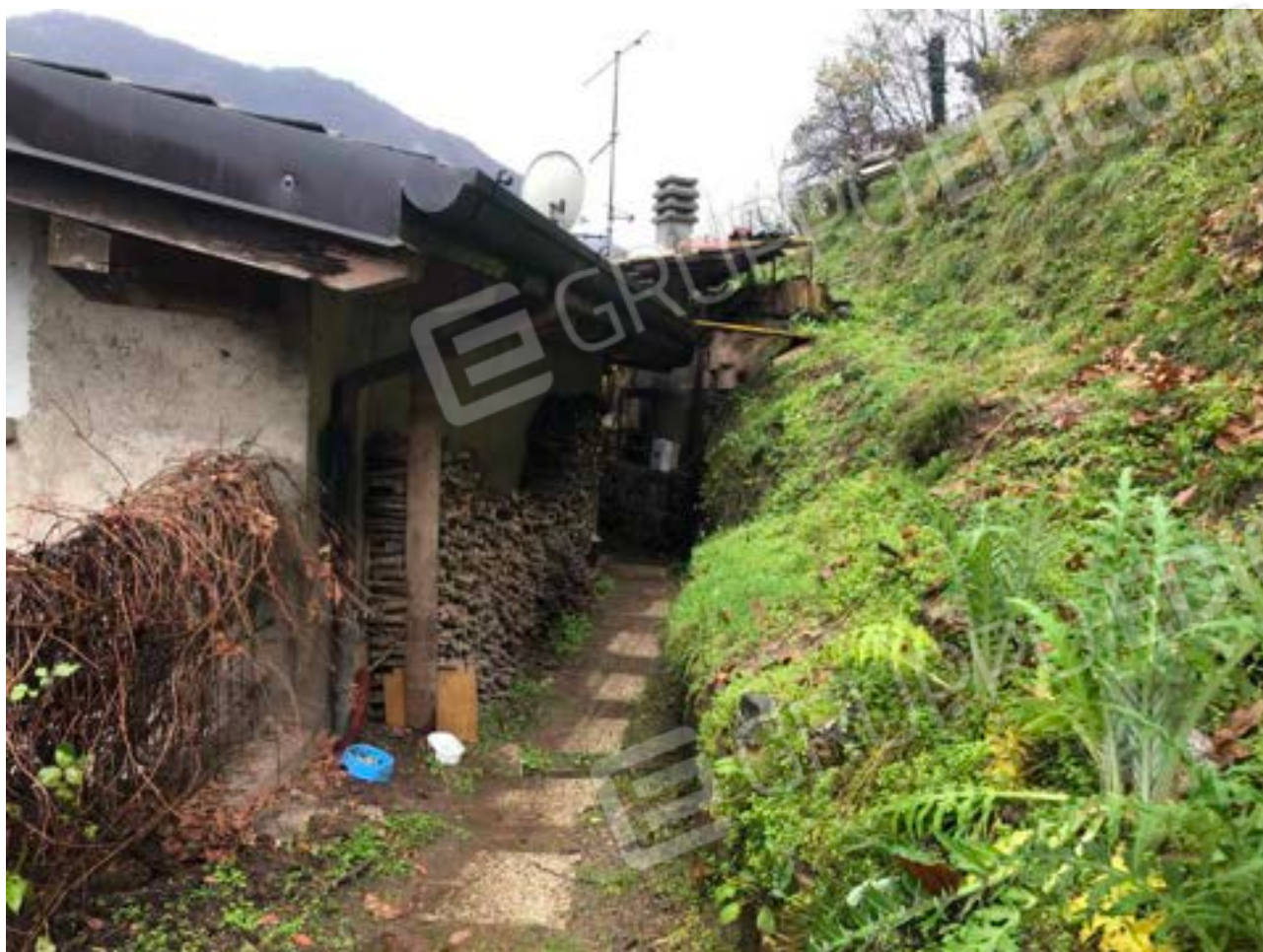
Foto n°17: Spazio antistante il fabbricato sul fronte ovest
