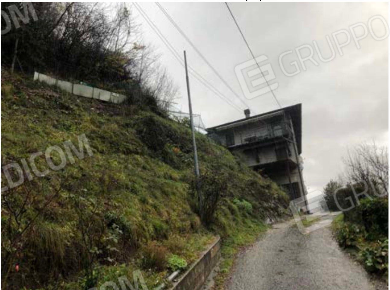
Foto n°36: Strada d'accesso alla proprietà
