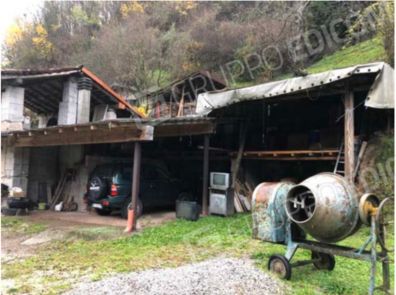
Foto n°25: Corpo di fabbrica n°1 con locali accessori (sub.4)
