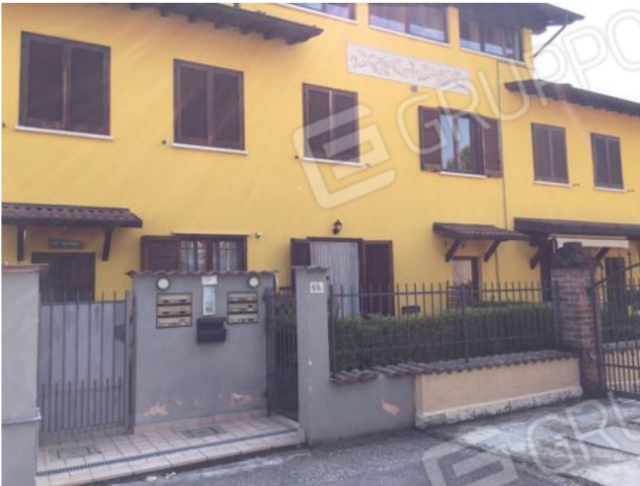
Ingresso pedonale su Via G. Carducci
