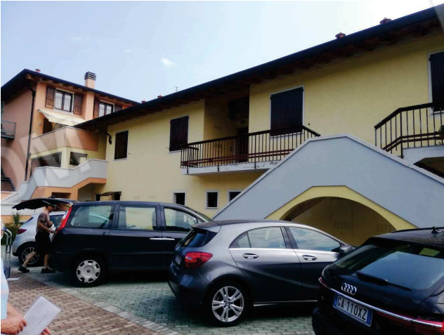
ingresso lato nord
