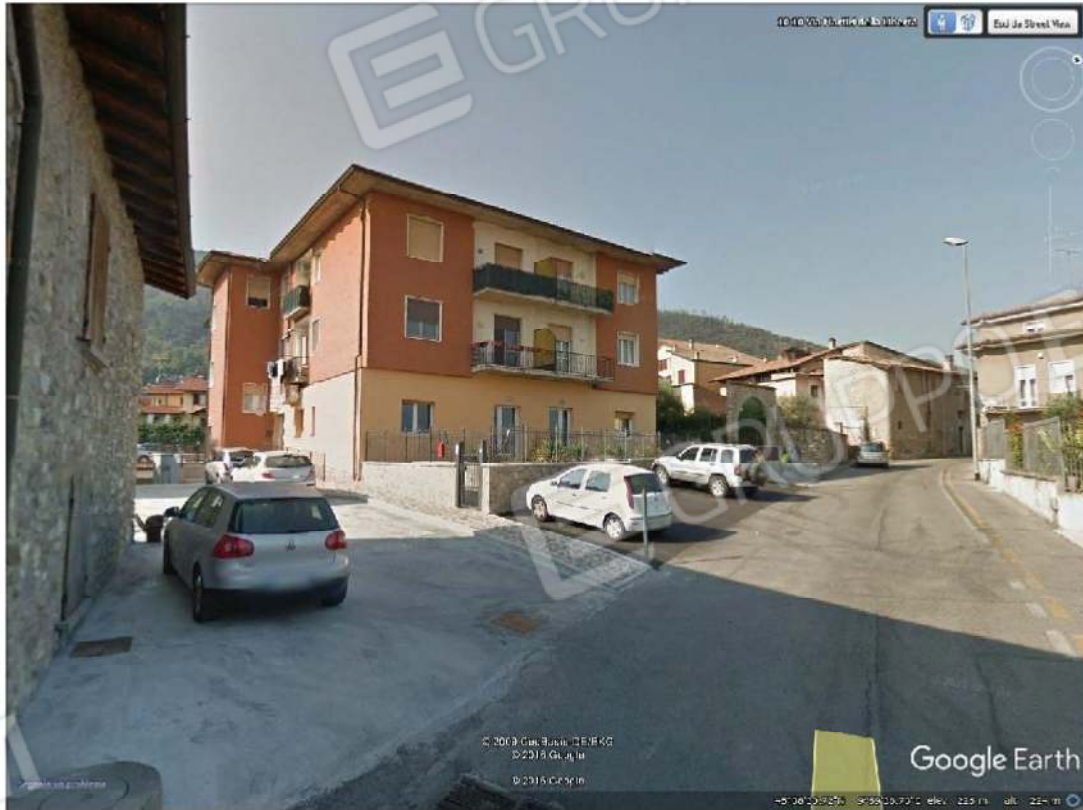
Vista angolo Sud-Est Condominio Rivetti da via Martiri della Libertà
