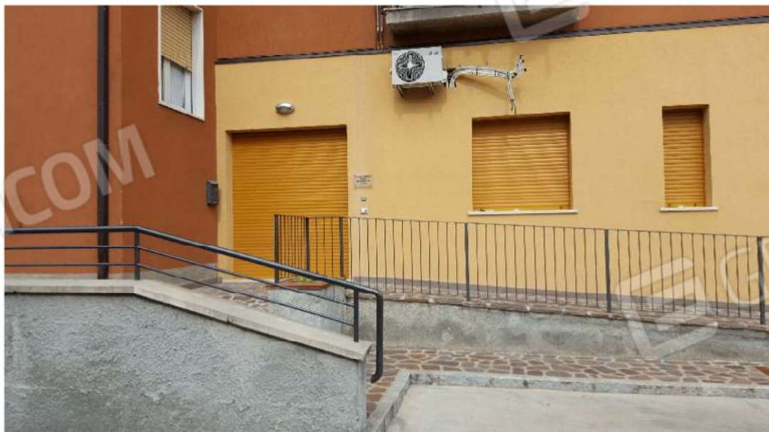
Vista fronte Sud ingresso ufficio
