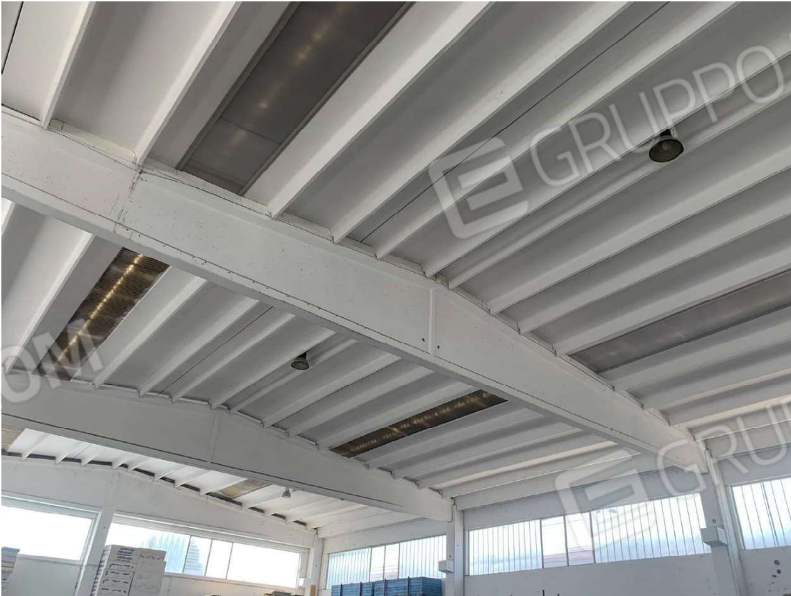
Foto 14. Vista interna del tetto del capannone
