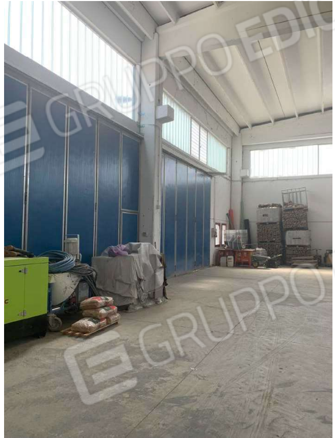
Foto 16. Vista interna di due portoni di accesso
