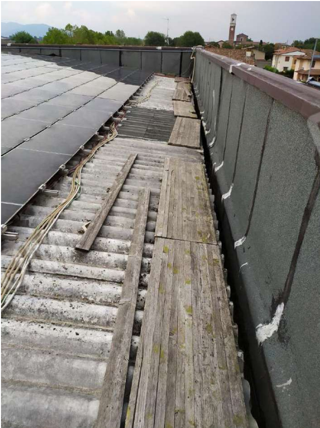
Foto 29. Stato di conservazione parte della copertura
