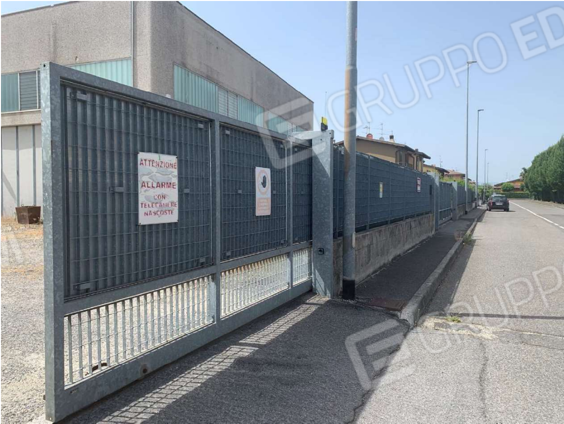
Foto 3. Ingresso carraio al capannone e all'area di pertinenza
