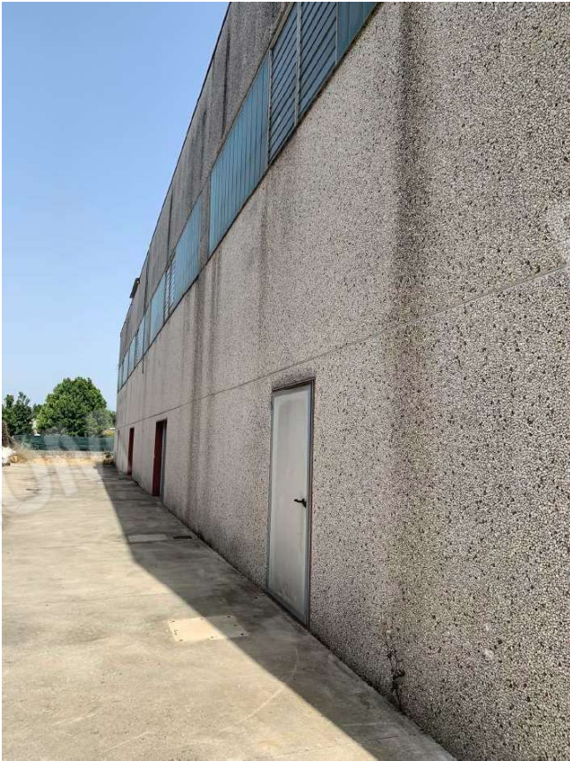
Foto 5. Vista esterna lato nord del capannone
