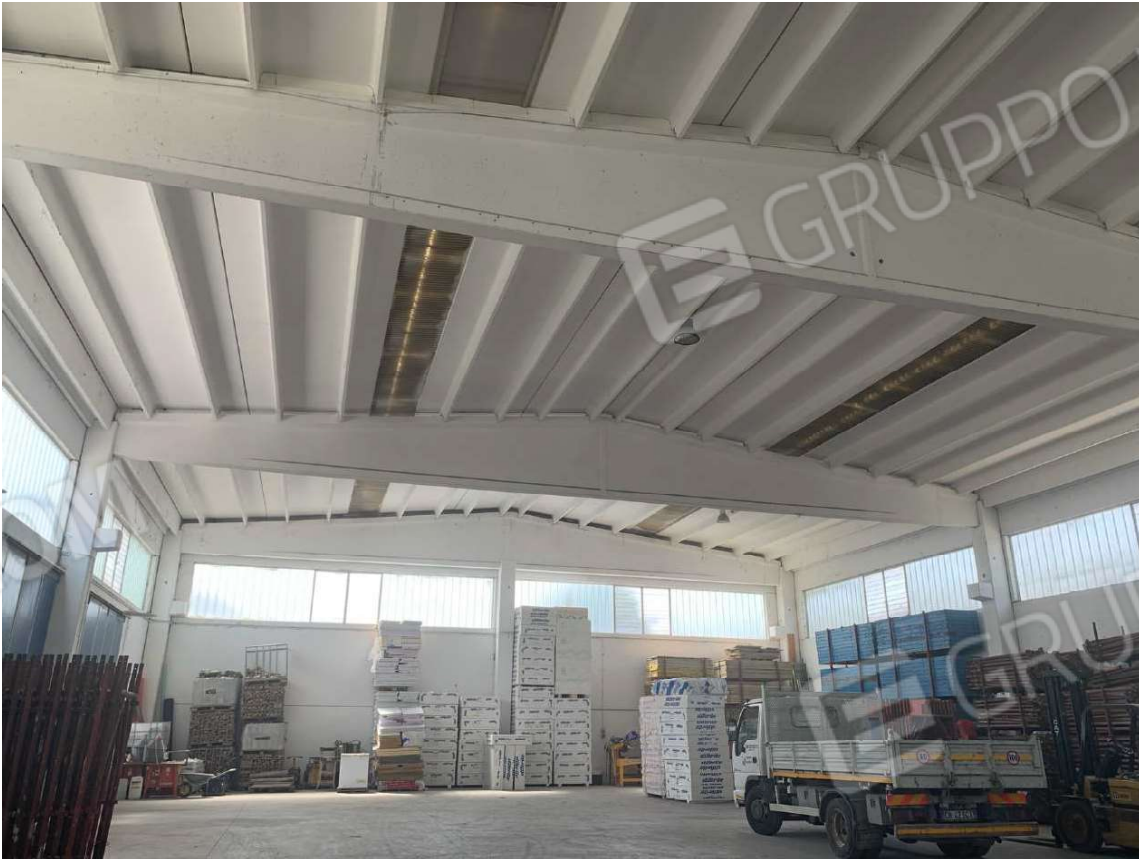
Foto 12. Vista interna generale di una porzione di capannone
