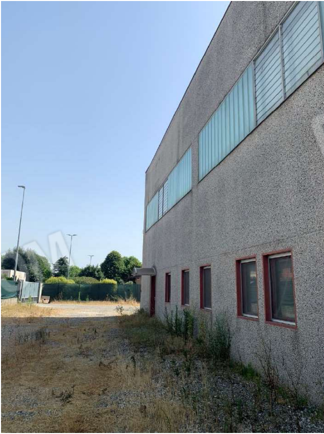
Foto 7. Vista esterna lato est del capannone
