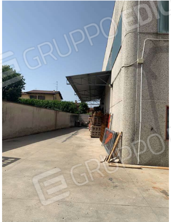
Foto 6. Vista esterna lato ovest del capannone
