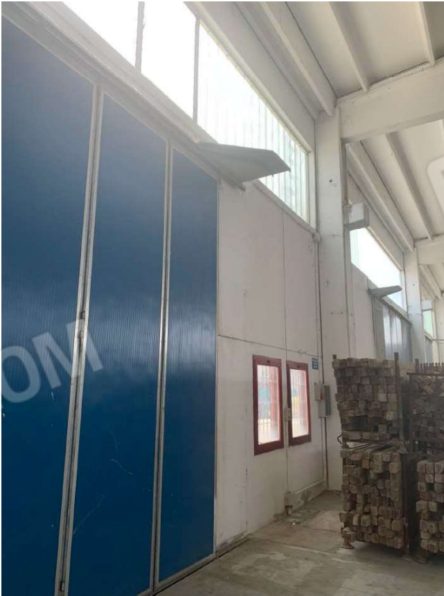
Foto 9. Vista interna di uno dei portoni di accesso al capannone
