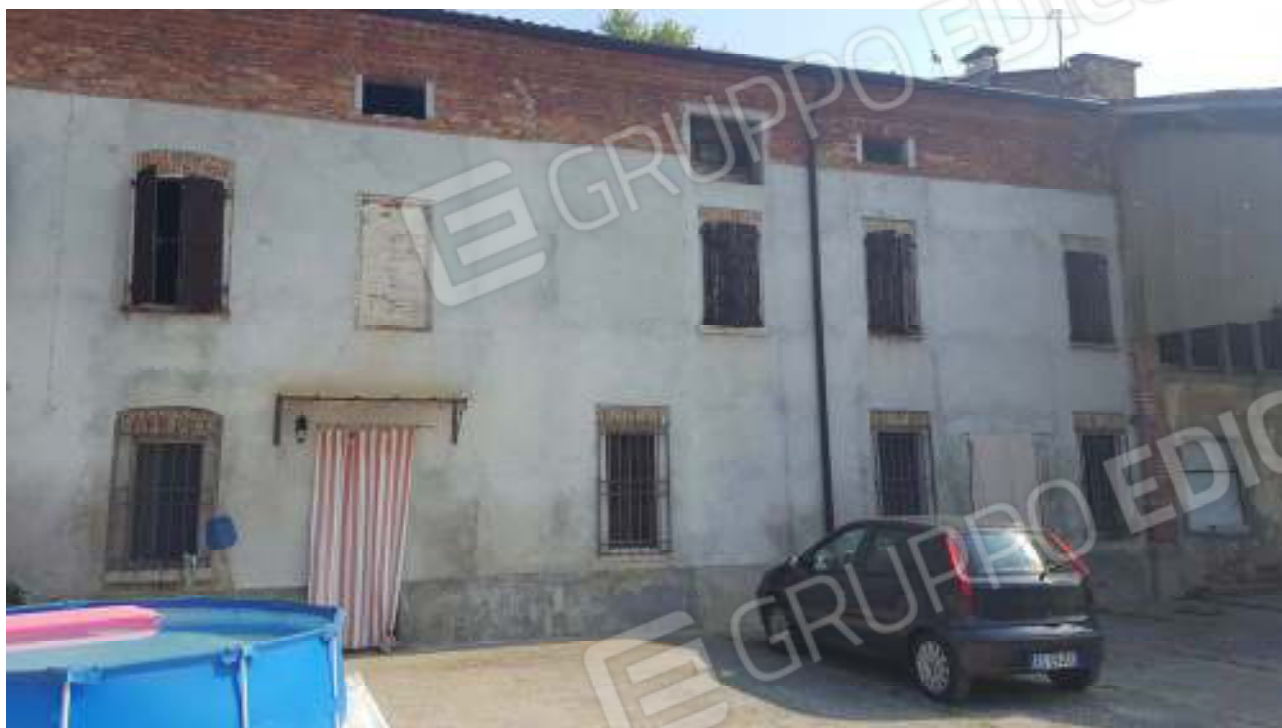
9-Fronte Sud edificio lotto 2 – Mapp.le 26 Sub.10
