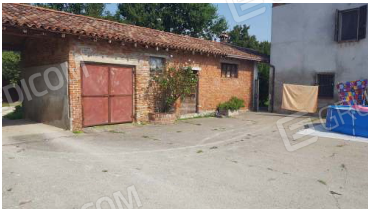
foto 10 – corpo accessorio cantine e androne ingresso carraio Mapp.le 26 Sub.10
