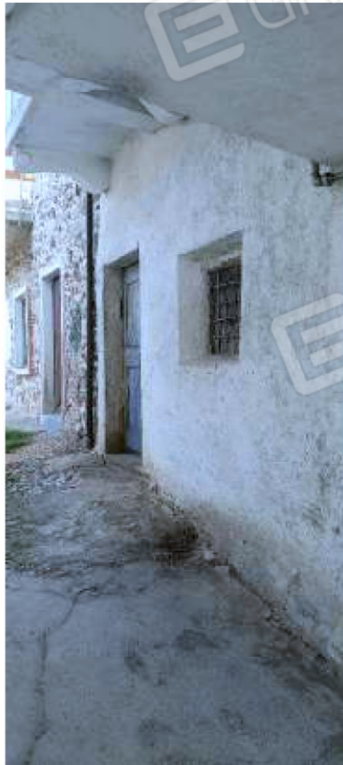
Ingresso alla cantina
