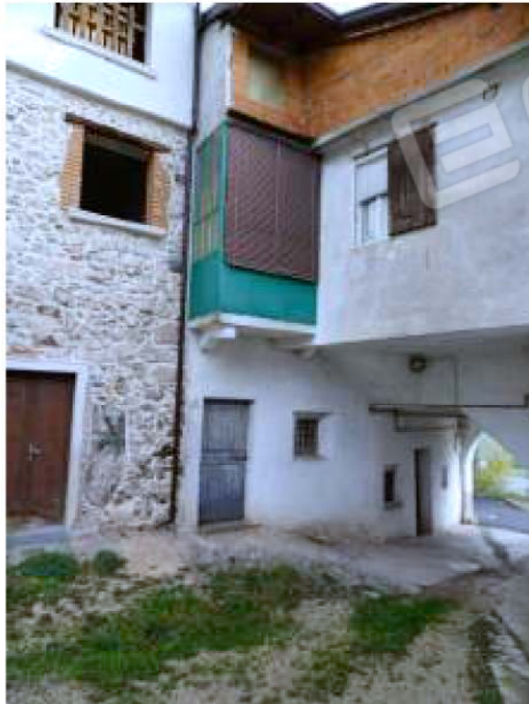
Esterno del corridoio al piano ammezzato
