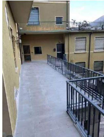
Figura 15: Vista della terrazza in direzione nord
