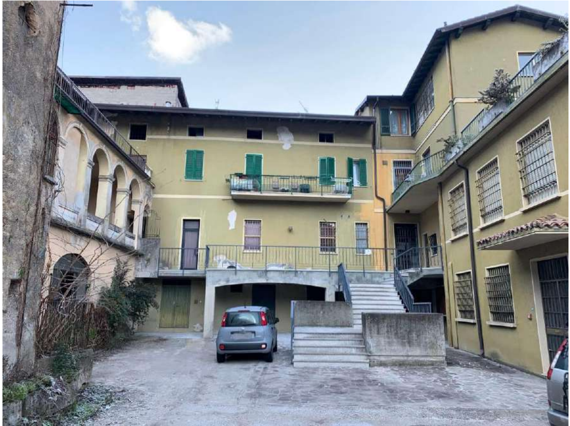
Fig. 04: Vista dell'edificio e della terrazza dal cortile comune retrostante (prospetto Est)
