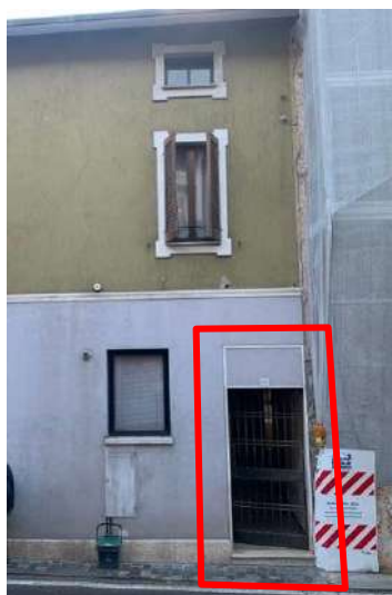
Fig. 12: Ingresso corridoio comune su via F. Glisenti al civ. 44
