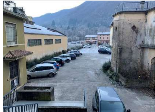
Figura 17: Vista della corte dalla terrazza
