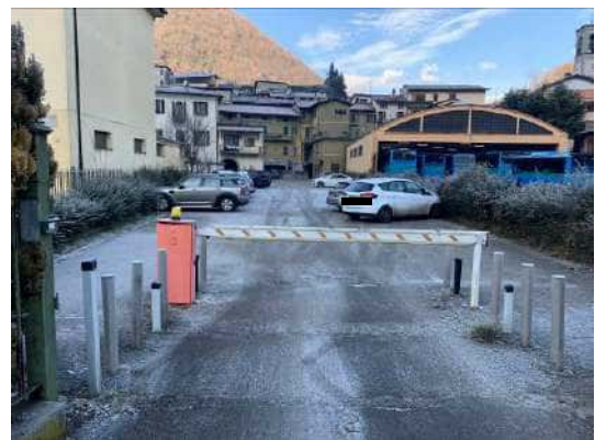
Figura 19: Vista dell'immobile dalla SS237. L'ingresso dà accesso alla corte confinante di altra proprietà
