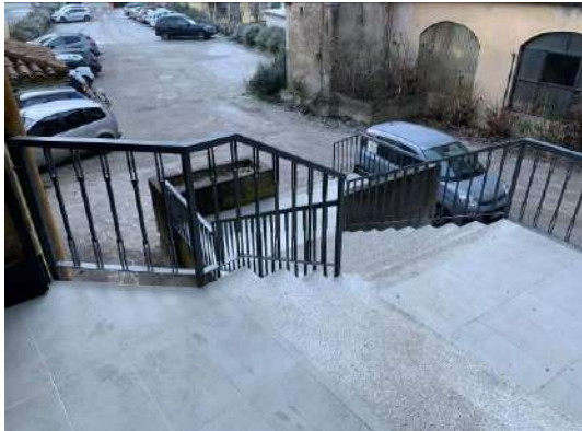
Figura 16: Rampa scale che dalla terrazza dà accesso alla corte comune a quota inferiore
