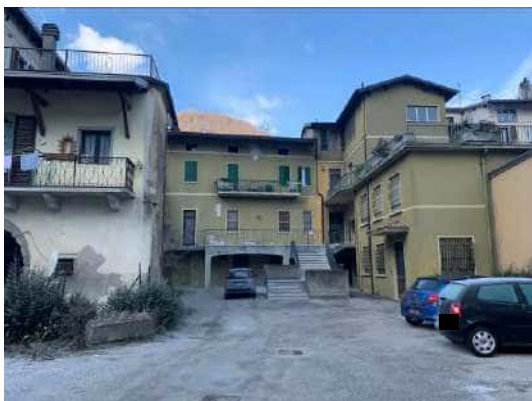
Figura 18: Vista del prospetto est dell'edificio e della corte comune il cui confine non è fisicamente identificato.
