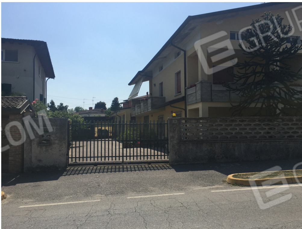
Fotografia 2 – Vista dell'ingresso carraio su Via Luigi Cadorna e del fronte sud-est
