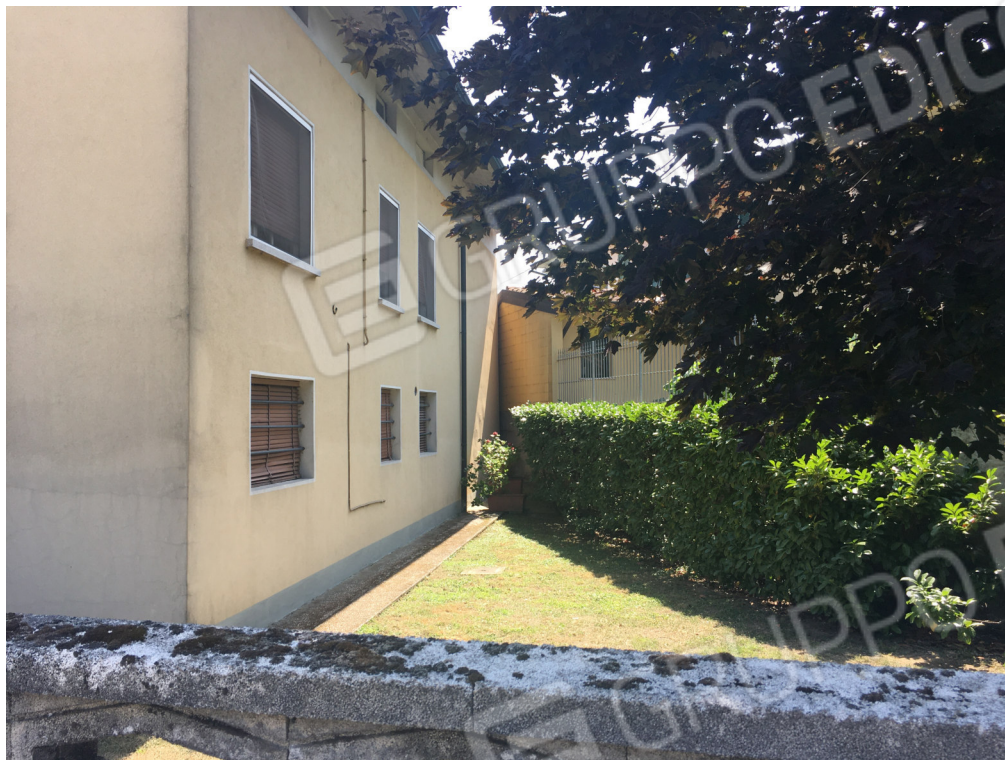
Fotografia 3 – Vista del fronte nord-ovest dell'edificio residenziale
