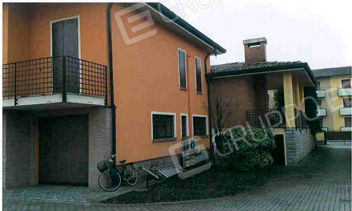
Vista esterna CORTE INTERNA - fronte NORD-EST
