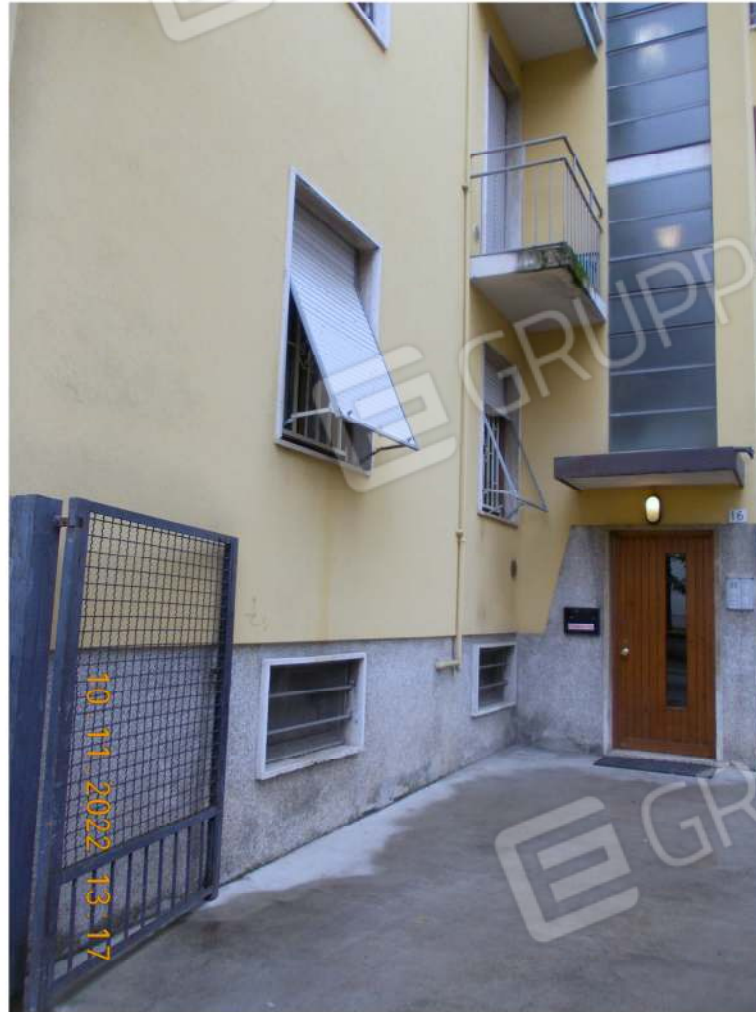
Fotografia 2 – Vista del fronte nord dell'immobile dalla corte di pertinenza affacciata su Via Gian Franco Omassi con ingresso al vano scala comune
