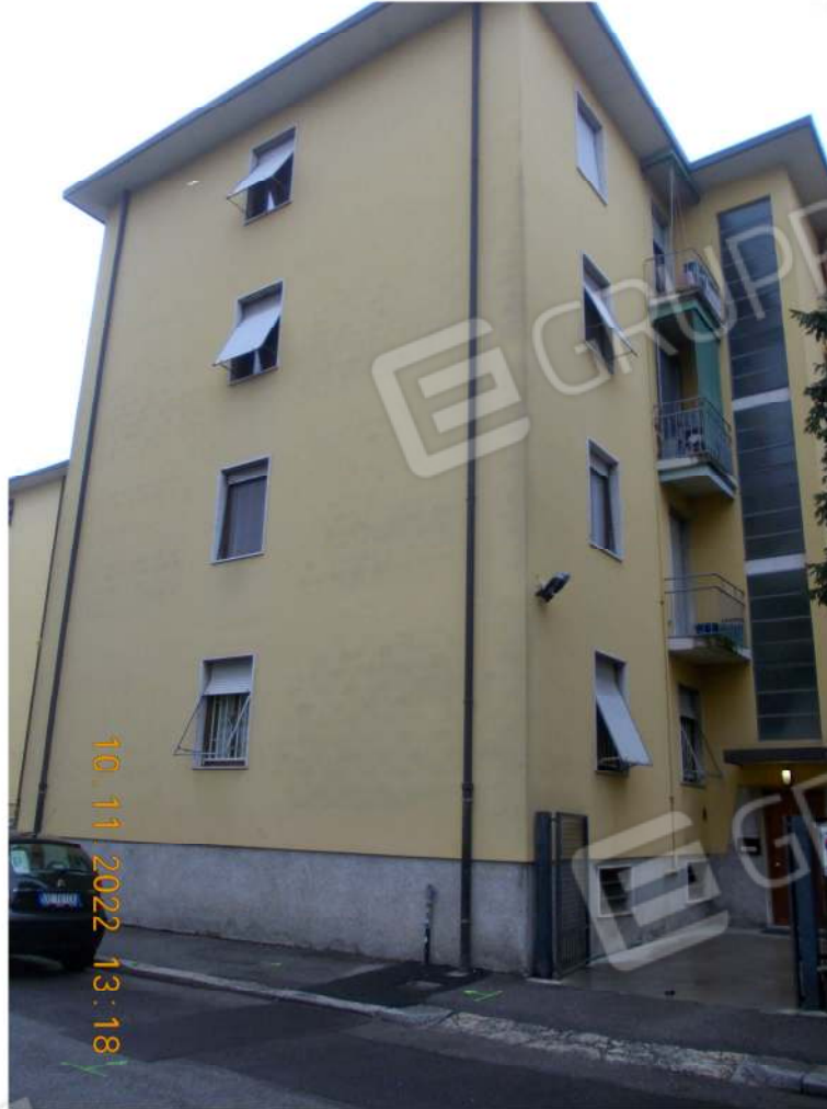
Fotografia 3 – Vista del fronte nord dell’immobile da Via Gian Franco Omassi con ingresso al vano scala comune
