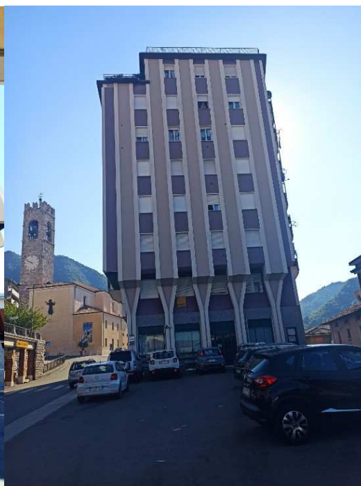
vista ovest (camera e parte bagno sottostanti al piazzale)
