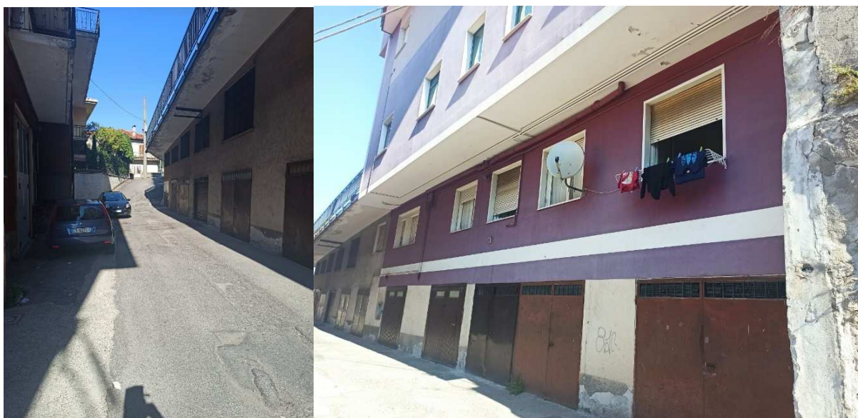
Vista da sud – dalla strada privata (soprastanti alle autorimesse si vedono le finestre dell'appartamento)
