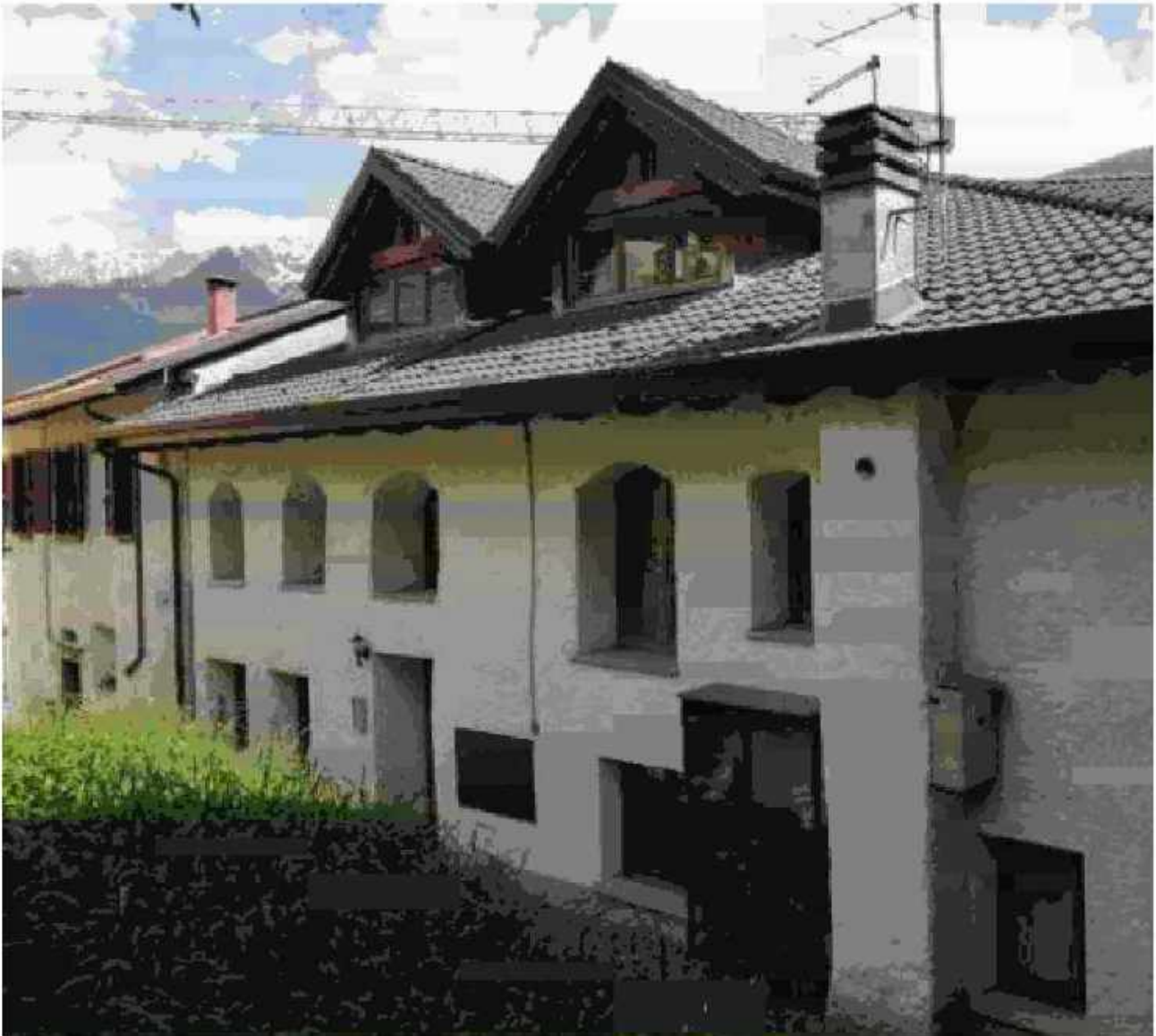
Facciata nord su cui hanno affaccio tutti i subalterni in oggetto
