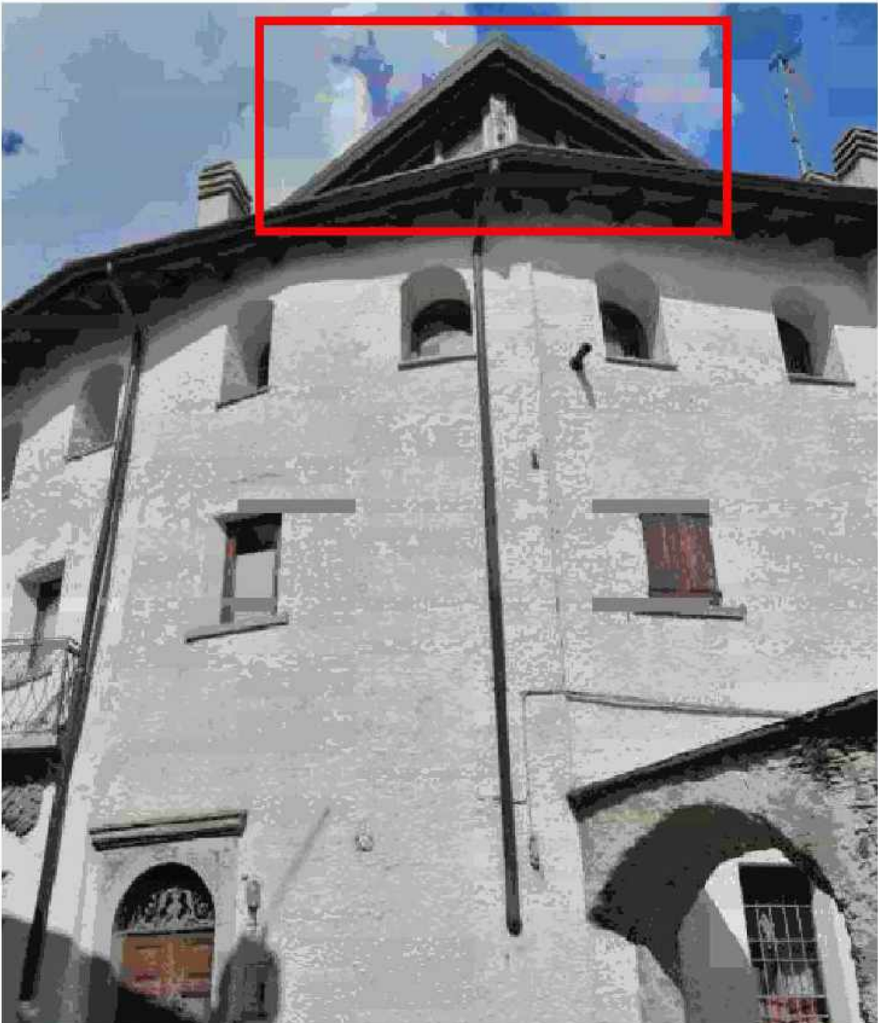
Facciata sud ovest su cui ha affaccio il subalterno 15
