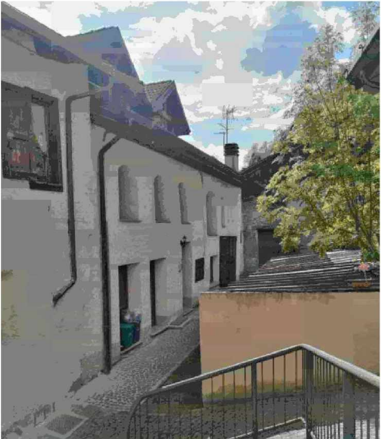
Facciata nord su cui hanno affaccio tutti i subalterni in oggetto
