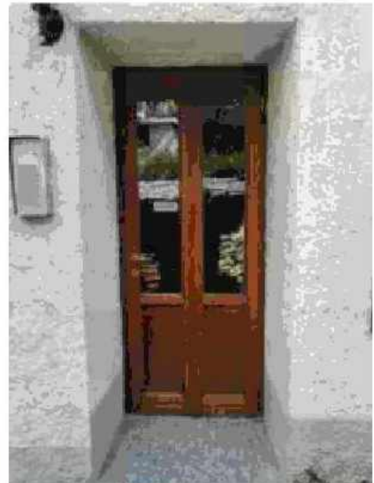
Porta d'accesso alla proprietà
