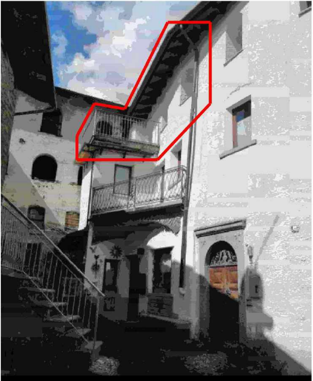
Facciata ovest su cui ha affaccio il subalterno 13
