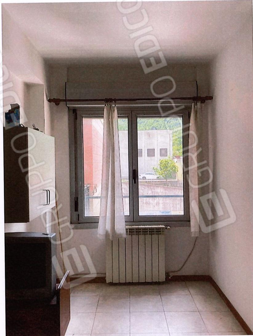
Figura 13: finestra della zona giorno. Essa non è sufficiente a garantire il rapporto aero-illuminante (R.A.I.) all'ambiente, come previsto per le abitazioni dal Regolamento di Igiene, ed è difforme rispetto al titolo edilizio rilasciato
