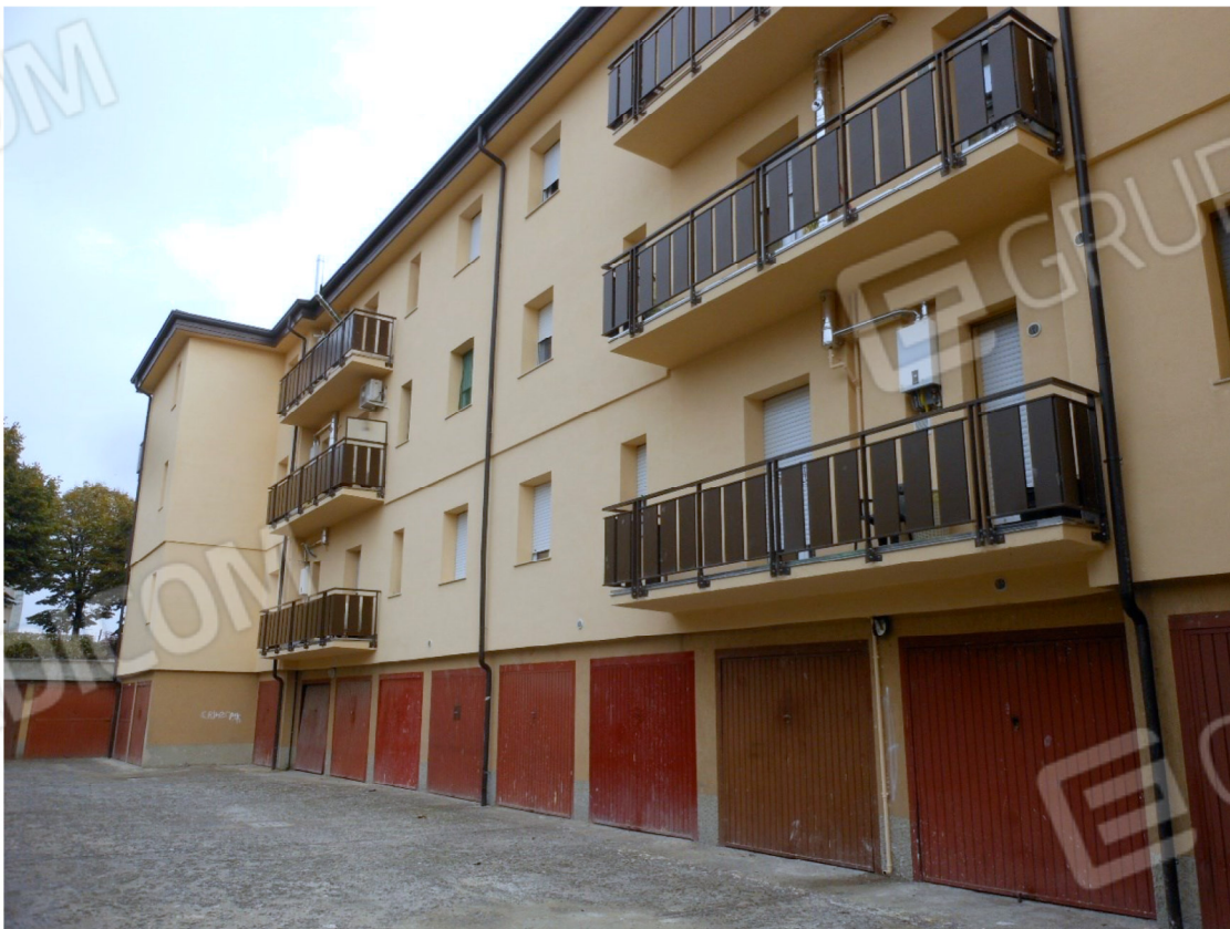
FOTO 12 – Accessi autorimesse (lato posteriore fabbricato)
