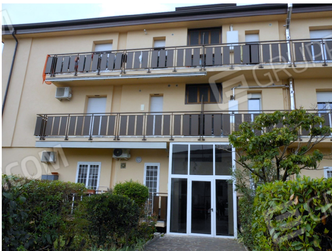
FOTO 2 – Dettaglio ingresso pedonale civico n. 104
