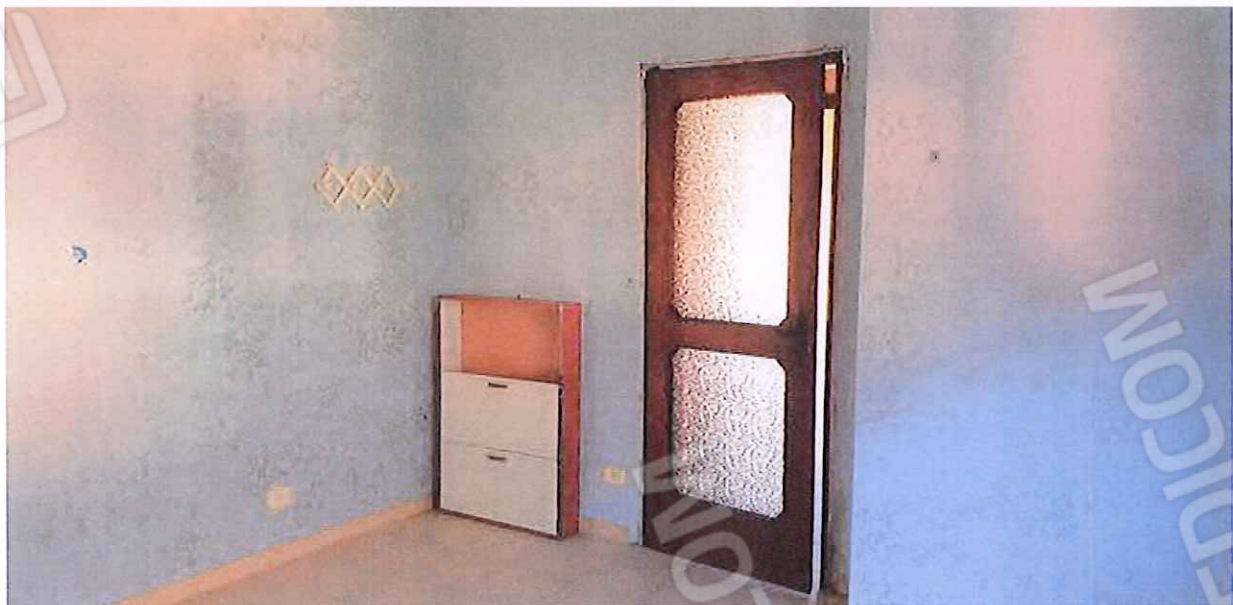
Foto 17 – camera Nord-Est – vista sud e ovest
