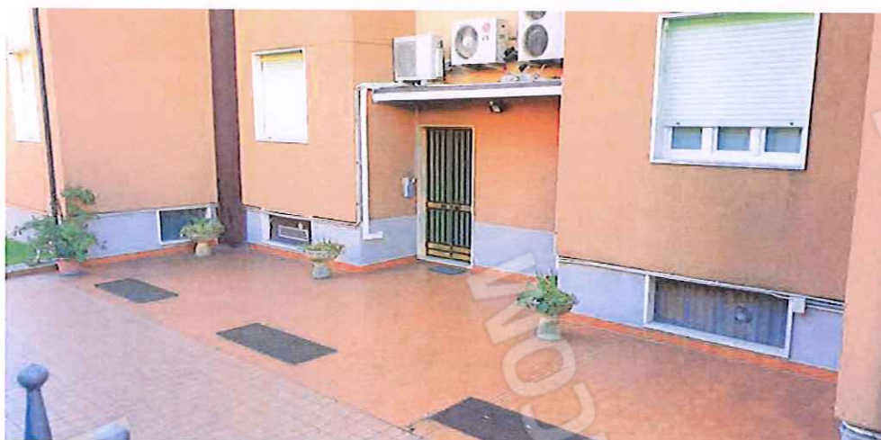
Foto 2 – Cortile Nord e ingresso scale
