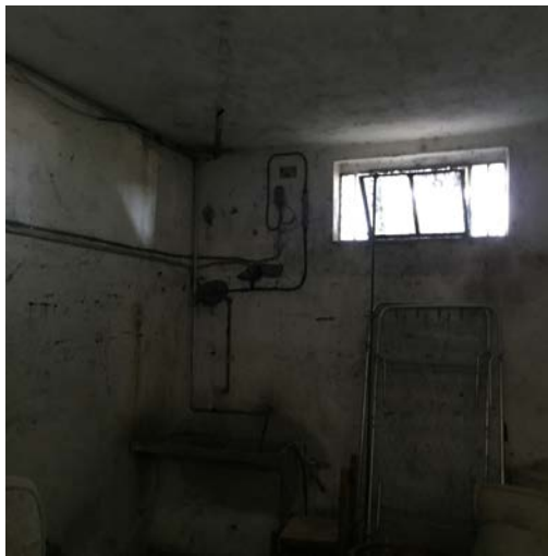
Foto degli interni delle cantine e dei relativi spazi comuni.
