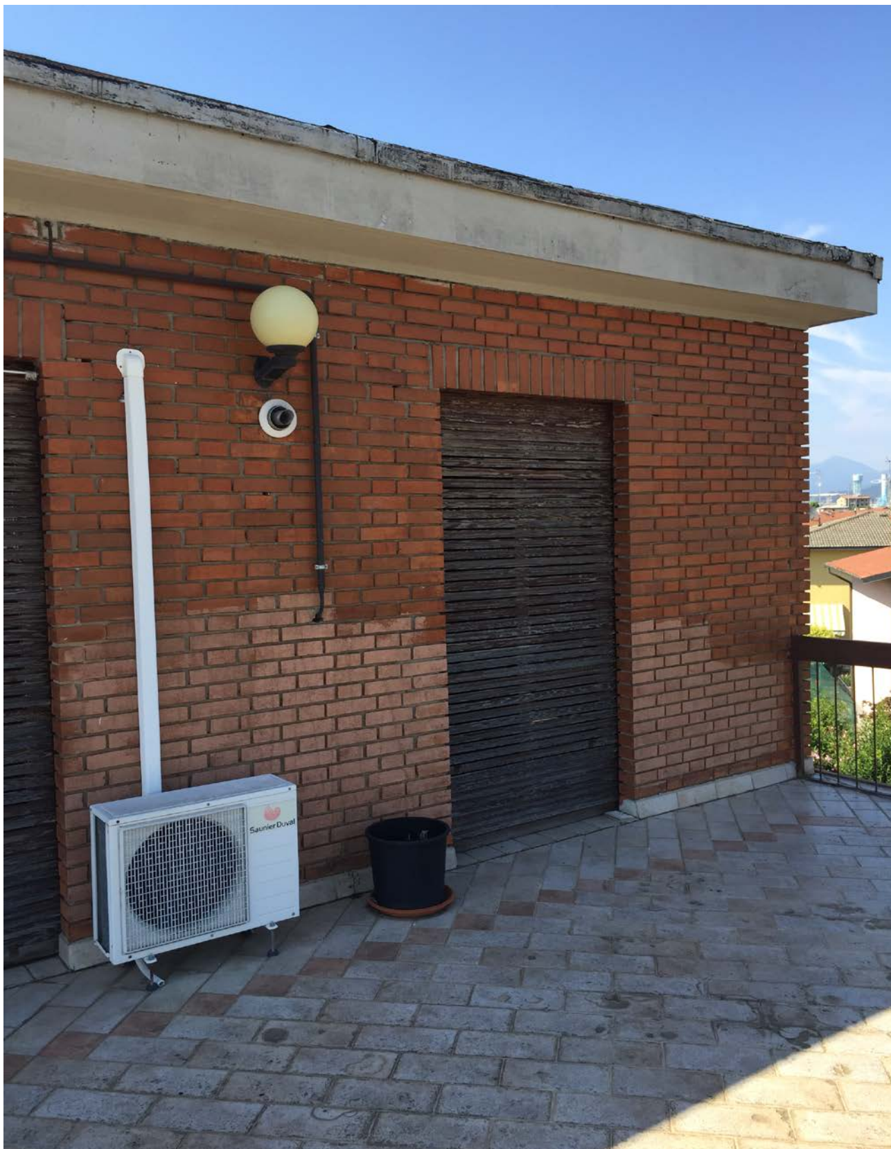
Foto esterna del terrazzo esclusivo e direttamente collegato all'appartamento del lotto 1E.
