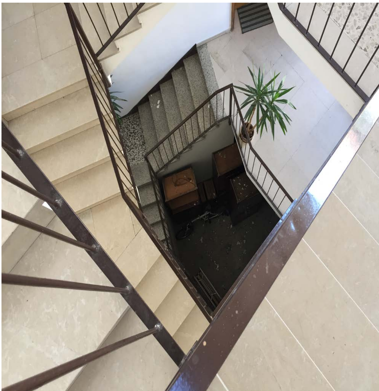
Foto del vano scala interno di tipo condominiale.
