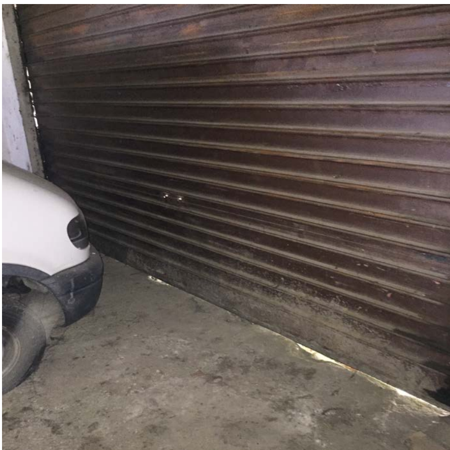
Foto degli interni dell'autorimessa posta a piano seminterrato.
