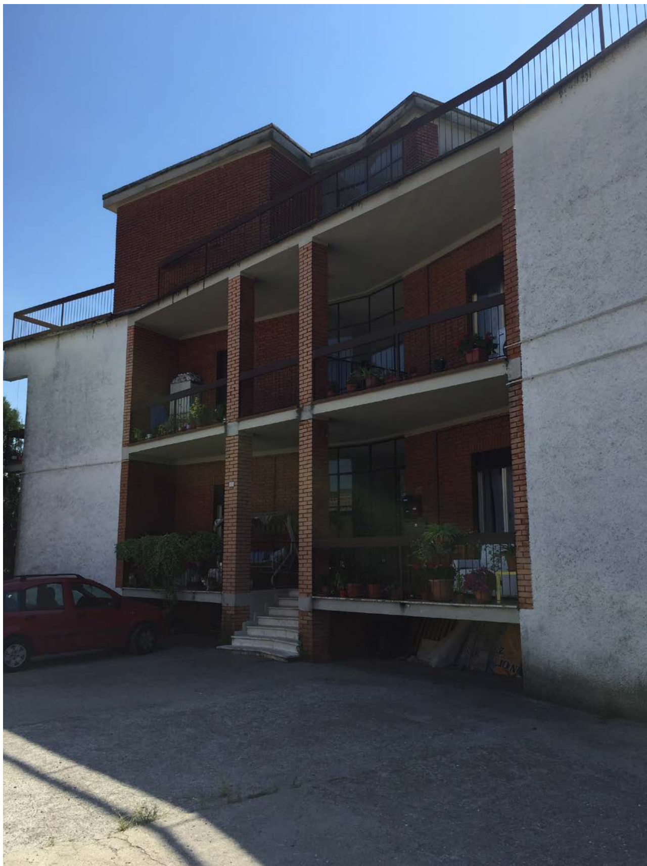
Fotografia dell'immobile oggetto di stima nel suo complesso dalla corte interna.
