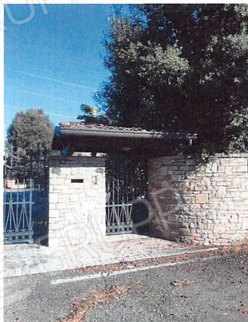
Ingresso pedonale e carroio
