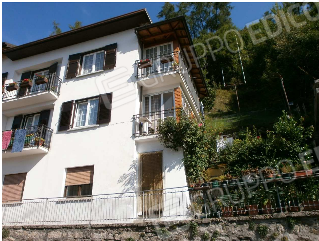
Dettaglio del lato sud; al primo piano la veranda del sub. 501
