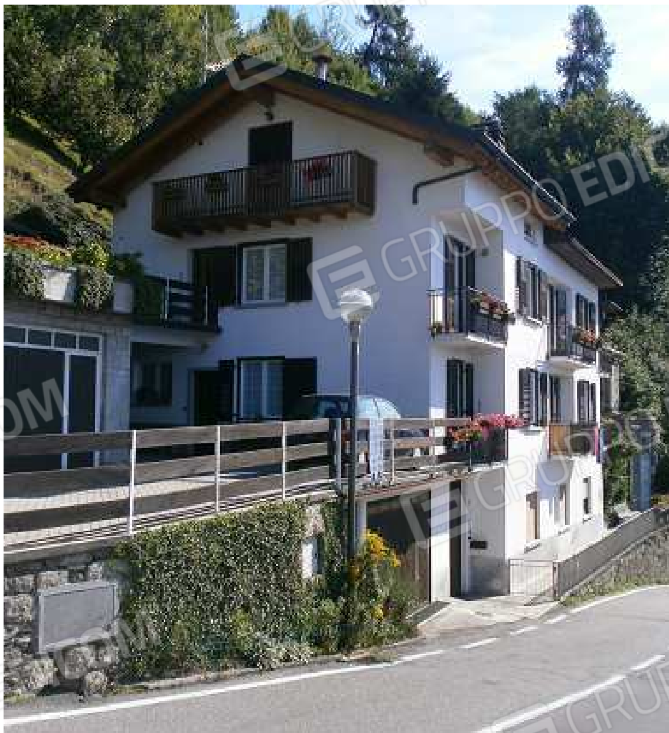
Vista complessiva del fabbricato da via Pineta; in evidenza i lati ovest e sud (sulla via)
