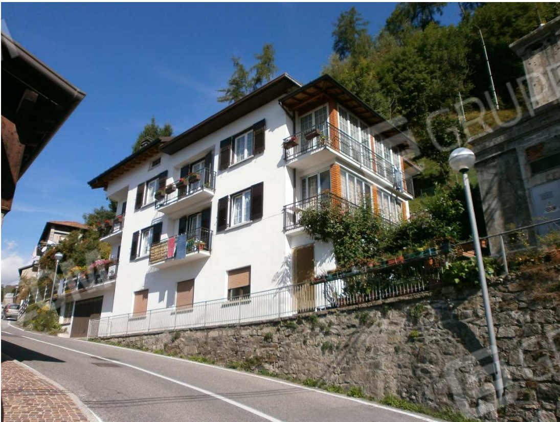
Vista del fabbricato da via Pineta; in evidenza il lato sud e parte del lato est, con le verande.
