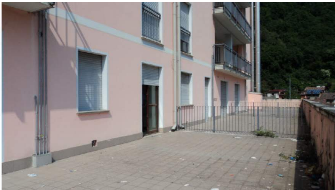
N. 9 - terrazza sul retro fronte sud
