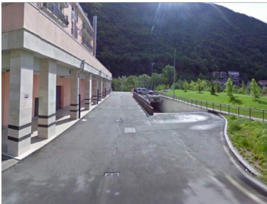
N. 7 - rampa ingresso box
