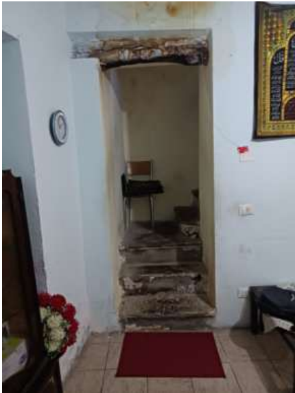
10, 11. Scala di accesso al piano primo
