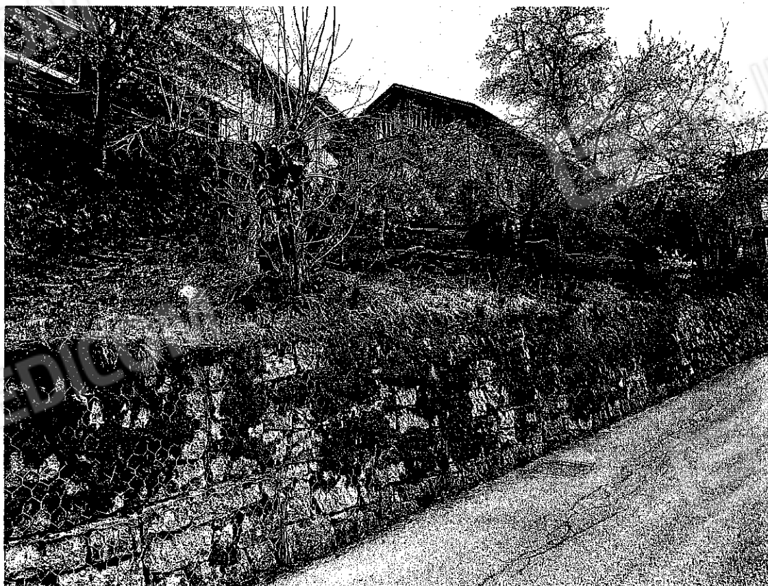
Vista terreni particelle nn. 5 e 271
