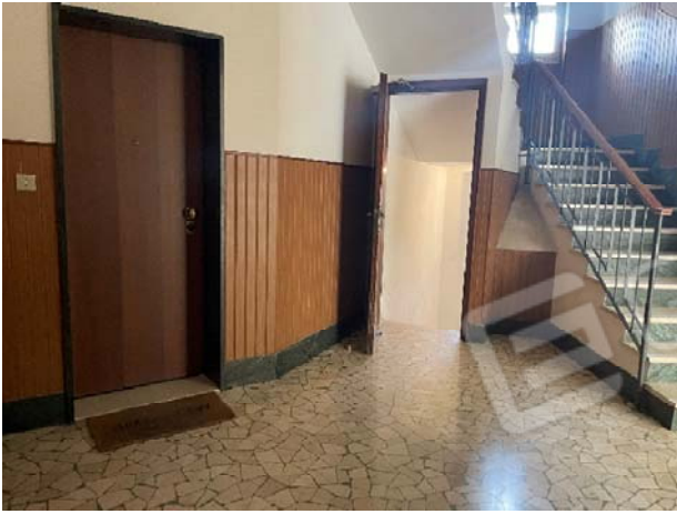
androne comune piano terra
