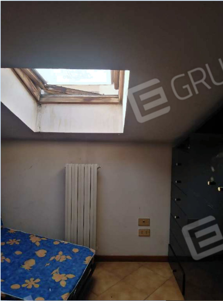
La Seconda Camera e il lucernario da sostituire
