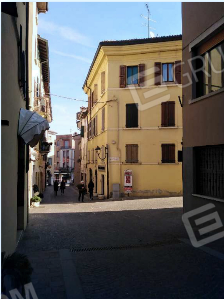
Vista del fabbricato che ospita i BENI 1 e 2 da Via Sant'Angela Merici angolo Via Carducci
