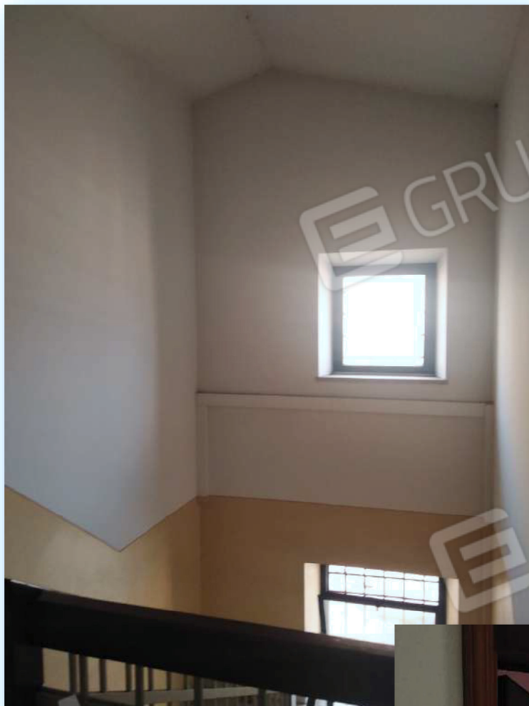
Il vano scala al Piano 3 (sottotetto)
