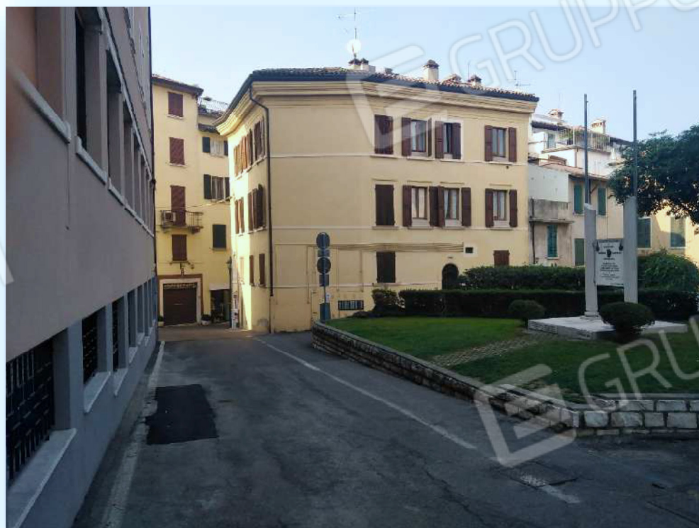
Vista del fabbricato che ospita i BENI 1 e 2 da Via Carducci
