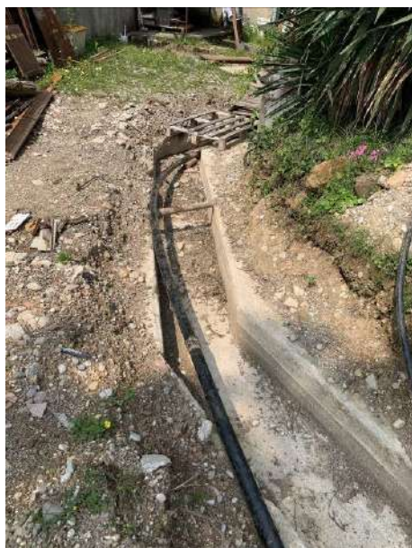
Figura 36: Scavi aperti con linee di sottoservizi a vista
