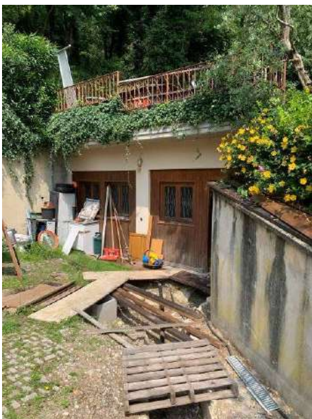
Figura 42: Autorimessa e taverna, scavi aperti con linee di sottoservizi a vista
