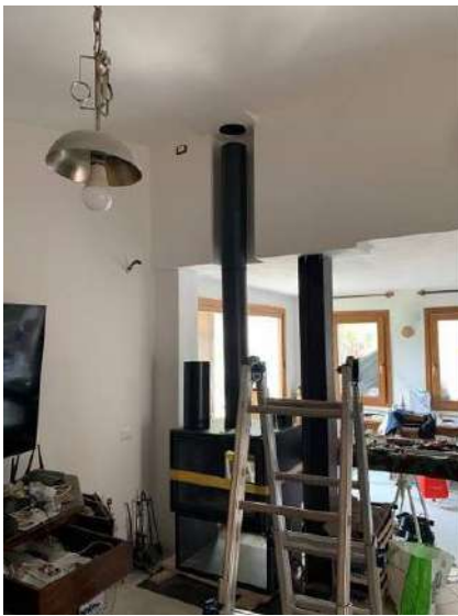
Figura 40: Piano terra abitazione, apparecchiature camino da completare
