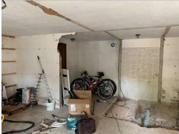
Figura 44: Autorimessa e taverna, lavori interrotti da completare con impianti e finiture
