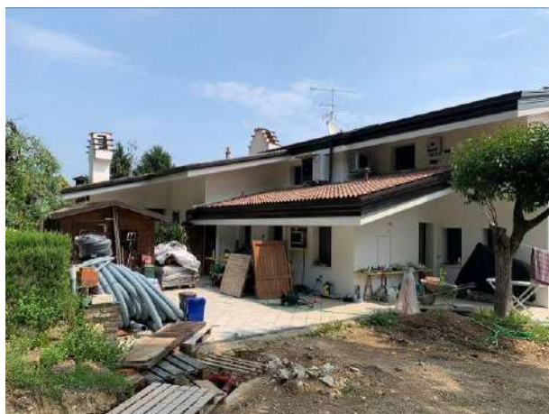
Figura 34: Presenza di scavi aperti per sottoservizi non ancora completati
