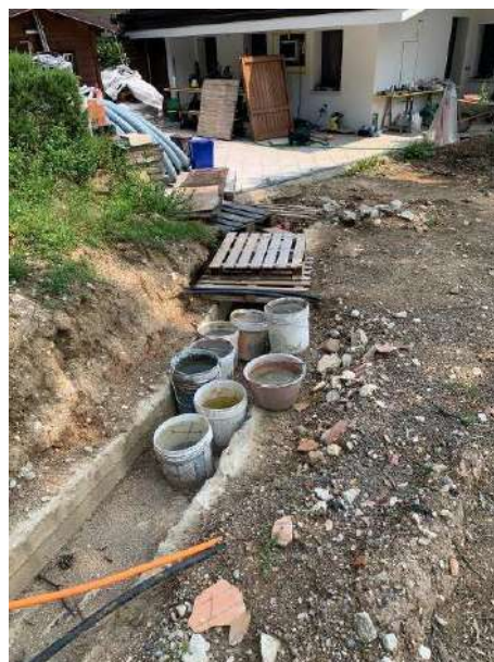
Figura 37: Scavi aperti con linee di sottoservizi a vista
