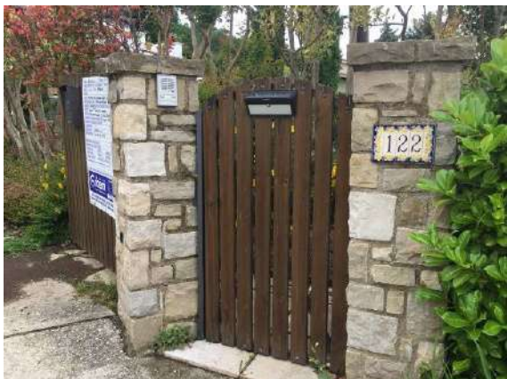
Fig. 11: Ingresso pedonale con a sinistra l'ingresso carraio alla proprietà
