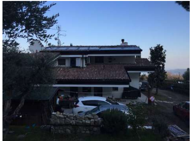
Figura 47: Vista falda ovest
