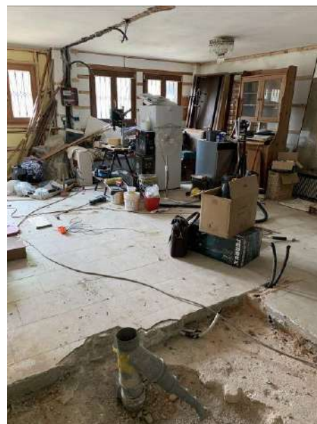
Figura 43: Autorimessa e taverna, lavori interrotti da completare con impianti e finiture
