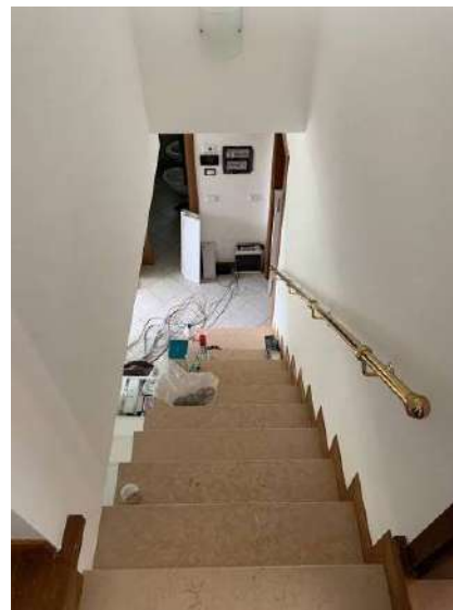
Figura 41: Piano terra abitazione, quadri elettrici da completare e componentistica a terra
