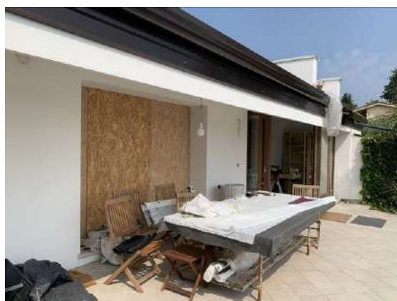
Fig. 14: Prospetto est prospiciente la piscina
