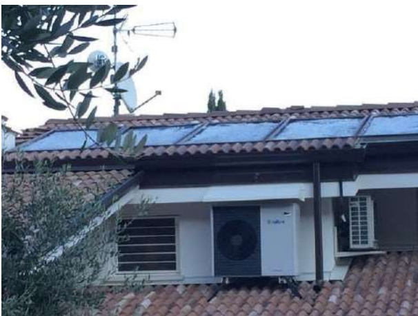
Figura 48: Vista falda ovest
