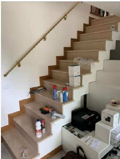
Fig. 19: Scala di collegamento con il piano primo
