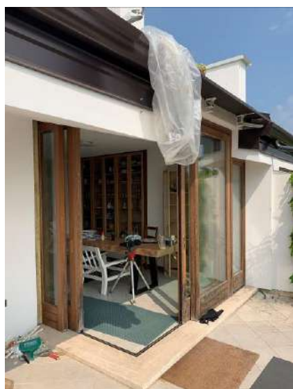
Fig. 15: Vista della finestrazione della zona pranzo prospiciente il giardino che ospita la piscina
