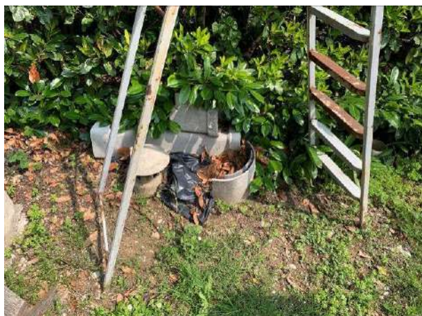
Figura 50: Canne fumarie in fibro cemento
