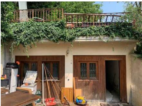
Fig. 23: Ingresso all'autorimessa (a sx) e alla taverna (a dx)
