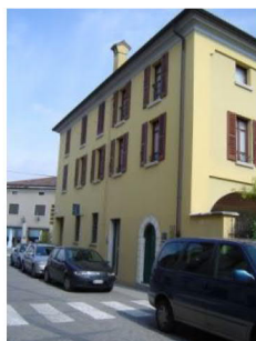
Foto 1 Prospetto su via Magenta
