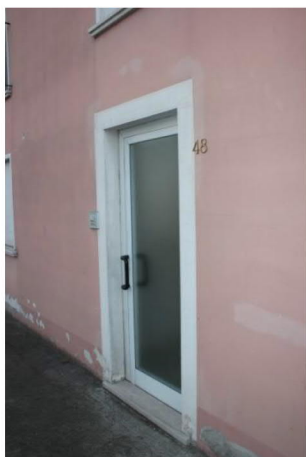
Foto 3 – Portoncino laterale del sub.3
