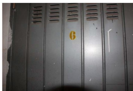
Foto 8 Cantina N.6 sub22
