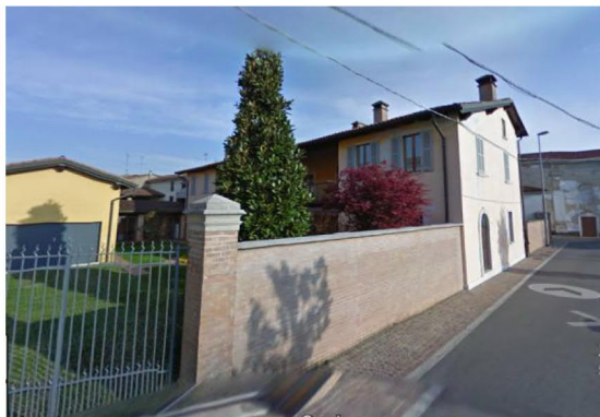
Foto 1 – ingresso su via San Faustino 43
