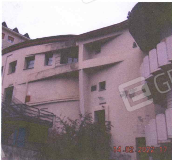
Vista esterno fabbricato da Via Massimo D'Azeglio
