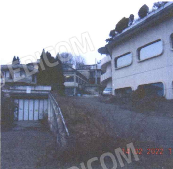
Percorso per accesso alla discoteca non realizzato
