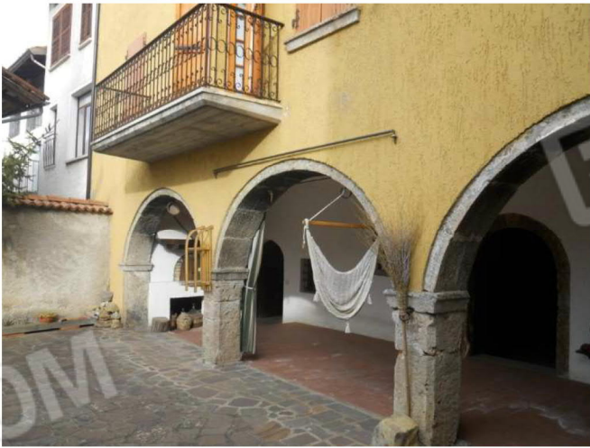
3 - Vista del portico dalla corte interna
