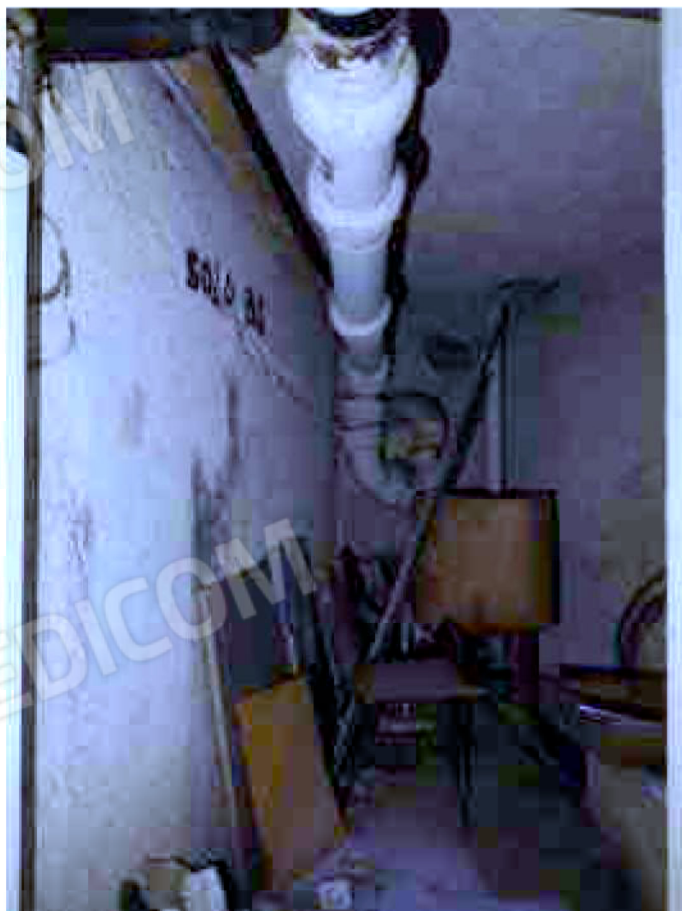
Fotografia 34 – Lotto 7 di 8 – Sub. 25; piano Interrato.
