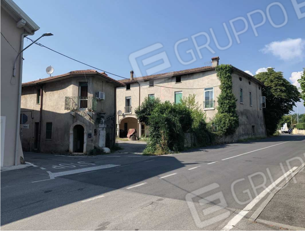
Ingresso Via Belvedere n. 4
