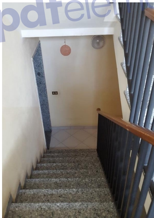
Scala con gradini e battiscopa in serizzo dal piano rialzato al piano primo.
