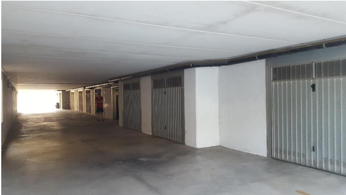
Corsello d'accesso alle autorimesse
