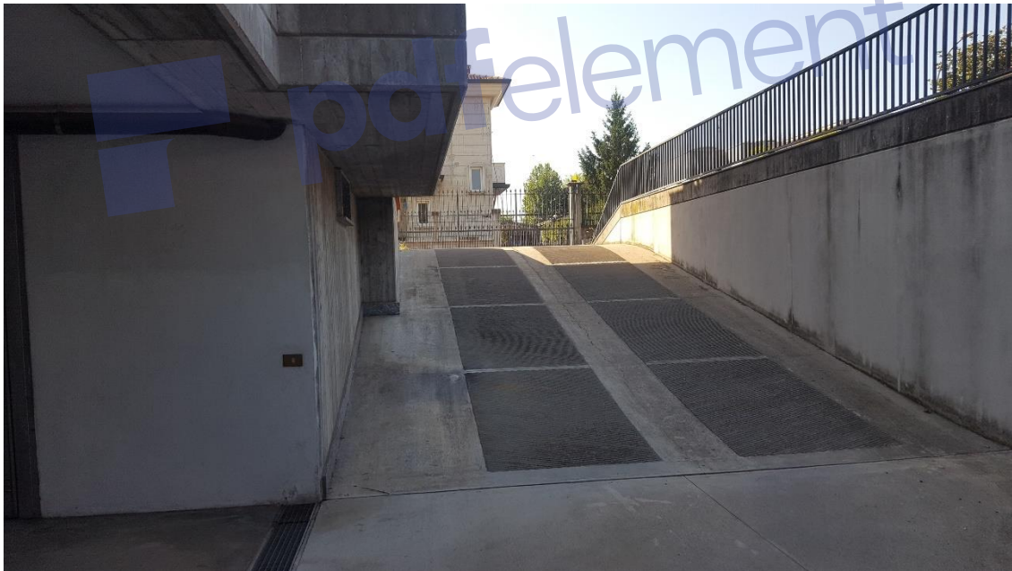
Rampa d'accesso alle autorimesse
