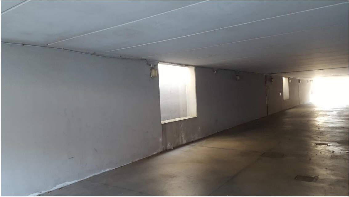
Cavedio per illuminazione naturale del corsello e lampade per illuminazione artificiale.
