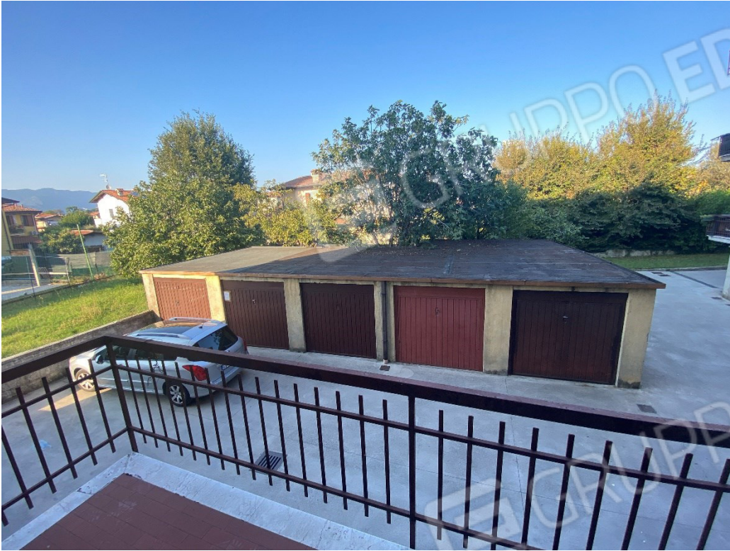
Autorimessa (vista esterna – l'autorimessa oggetto di perizia è la seconda da sinistra)
