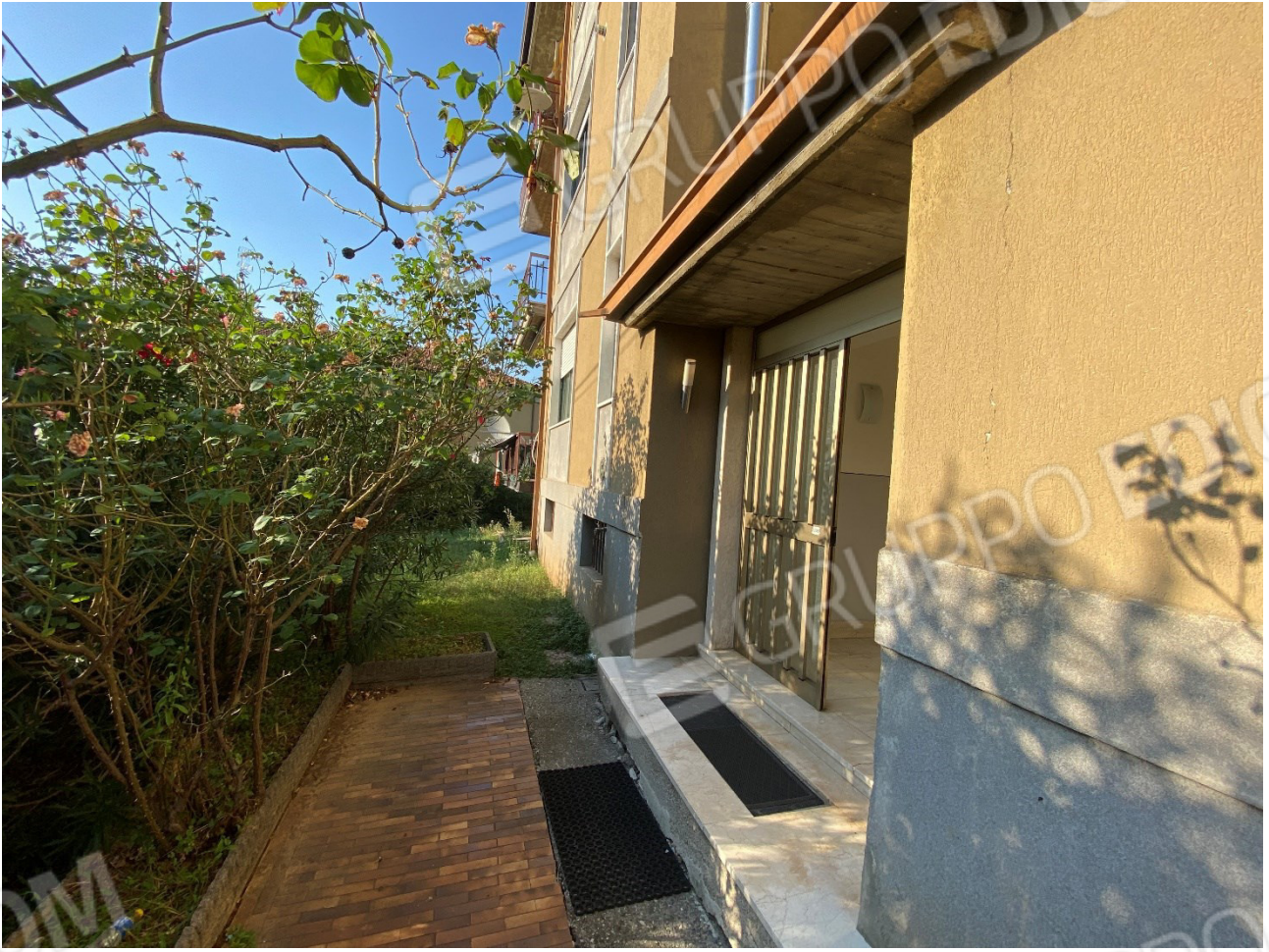
Ingresso vano scala
