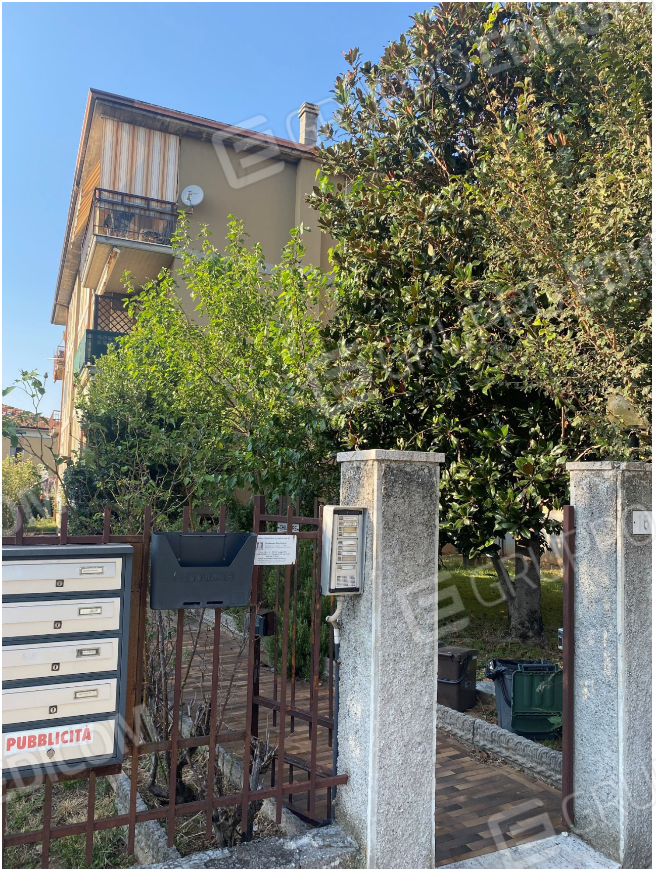
Ingresso pedonale condominio
