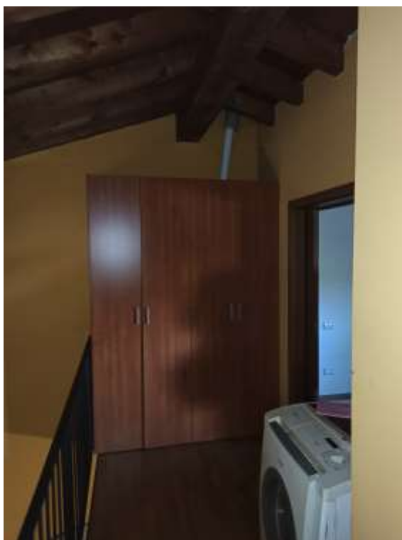
Foto 3.07: vista soppalco piano secondo
