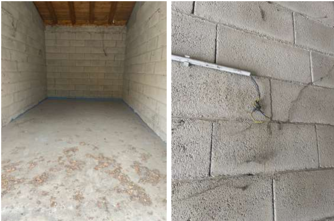
Foto 8.03 e 8.04: viste interne autorimessa
