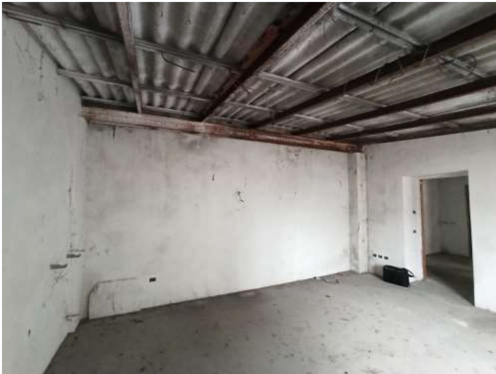
Foto 18.14: vista dettaglio copertura blocco nord
