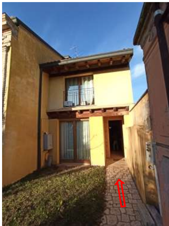
Foto 2.02: ingresso lato sud
