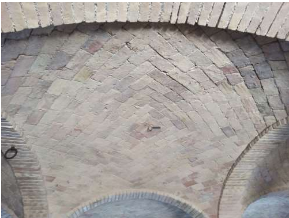
Foto 1.13: dettaglio soffitto a volte
