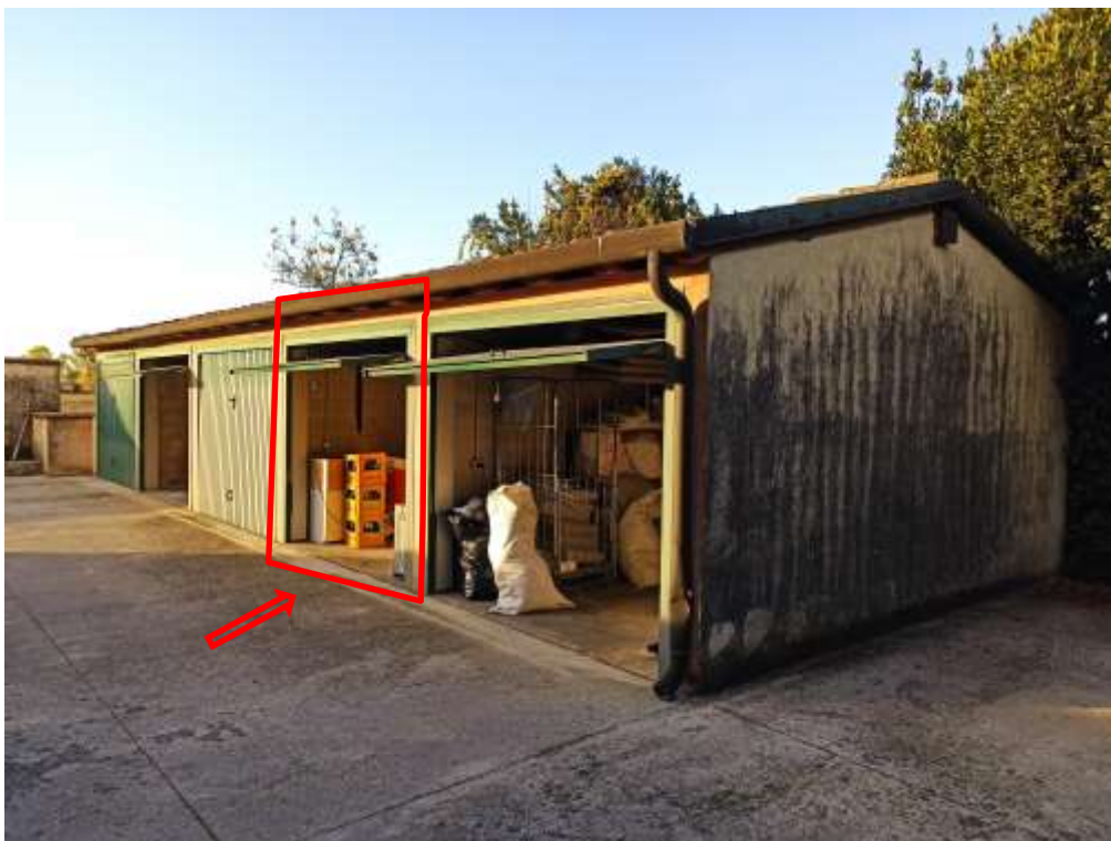
Foto 11.01: vista blocco autorimesse nord-ovest
