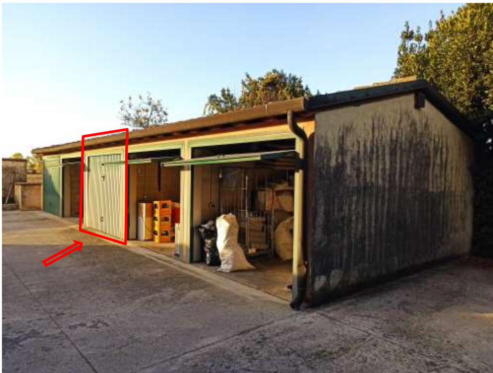
Foto 10.01: vista blocco autorimesse nord-ovest
