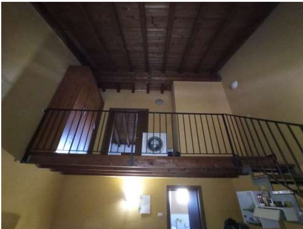
Foto 3.06: vista dall'ingresso del piano superiore
