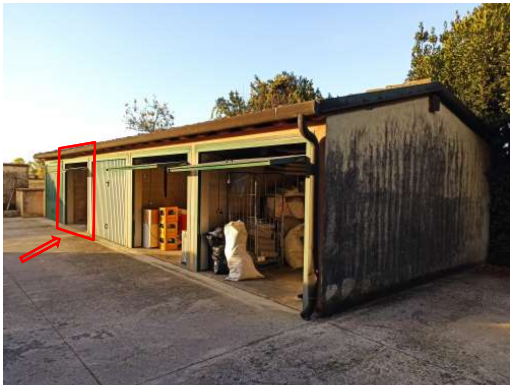
Foto 9.01: vista blocco autorimesse nord-ovest
