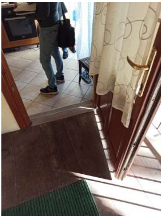
Foto 2.10: ingresso al piano primo da ballatoio a.u.i.
