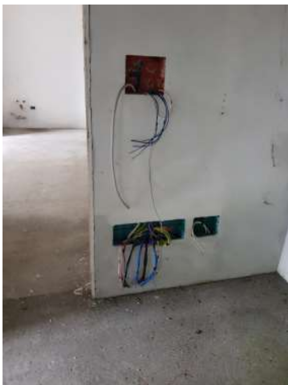
Foto 18.08 e 18.09: viste interne (predisposizione quadri elettrici/derivazioni e altri impianti)
