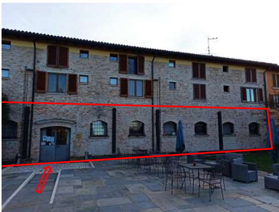
Foto 1.02: vista dell'ingresso da nord
