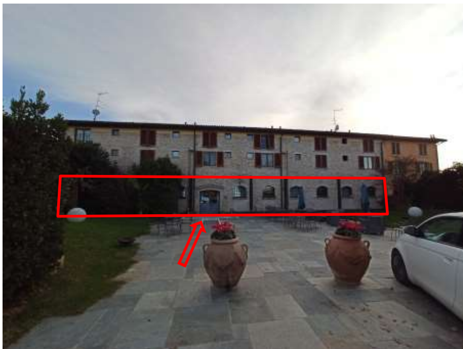
Foto 1.01: vista dell'ingresso da nord
