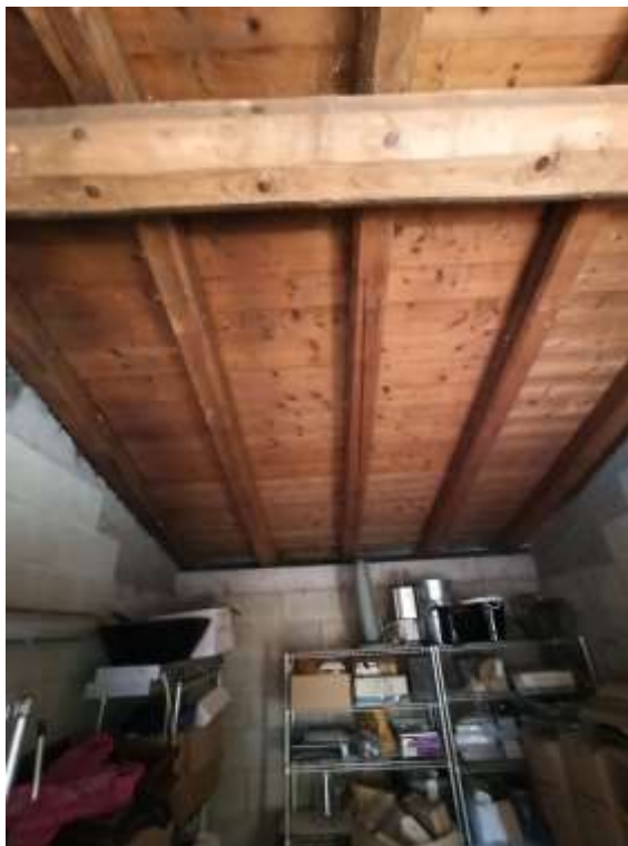
Foto 11.03: vista copertura lignea
