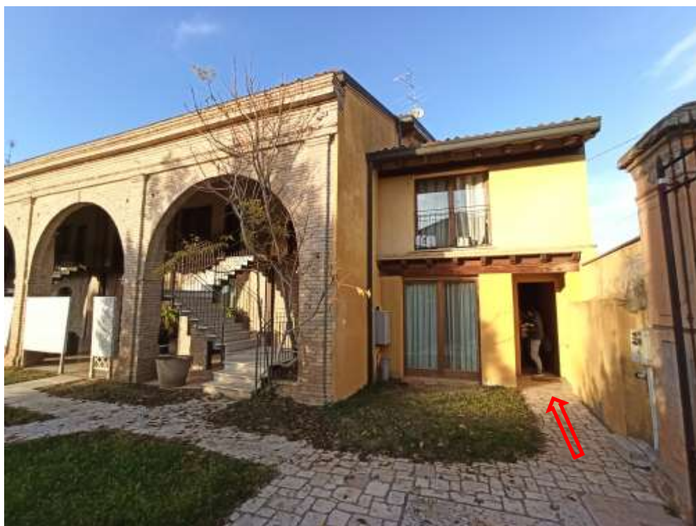
Foto 2.01: ingresso delle camere a piano terra e corte esclusiva, lato sud
