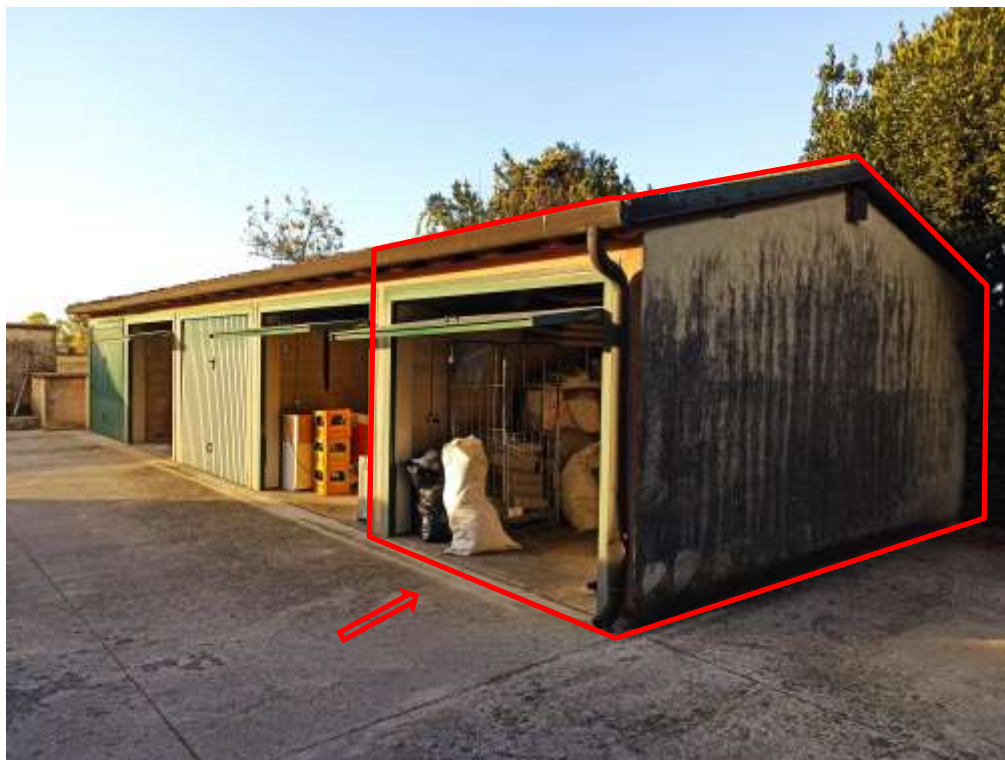
Foto 12.01: vista blocco autorimesse nord-ovest
