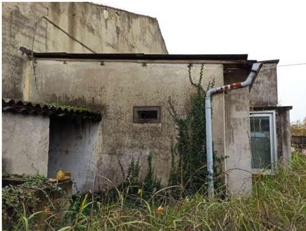
Foto 18.17: vista spazi esterni lato nord
