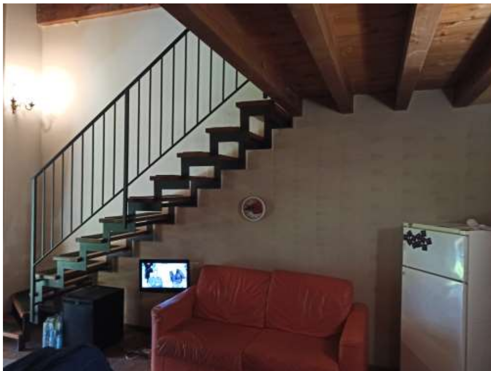
Foto 4.07: scala di collegamento al piano secondo
