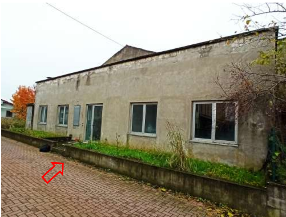
Foto 18.02: vista facciata ovest
