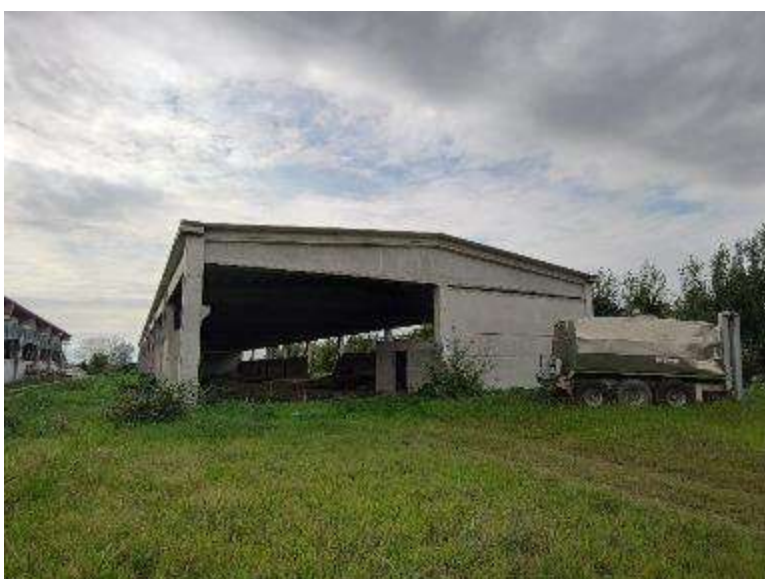
All. 16 – Particella 96 lato Nord
