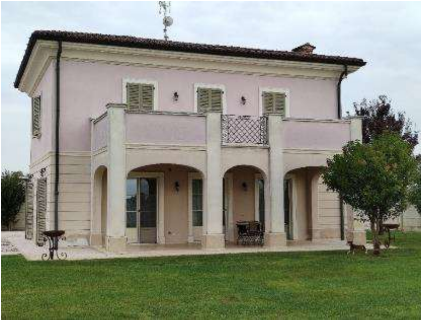
All. 12 – Particella 608 sub. 4 lato Sud
