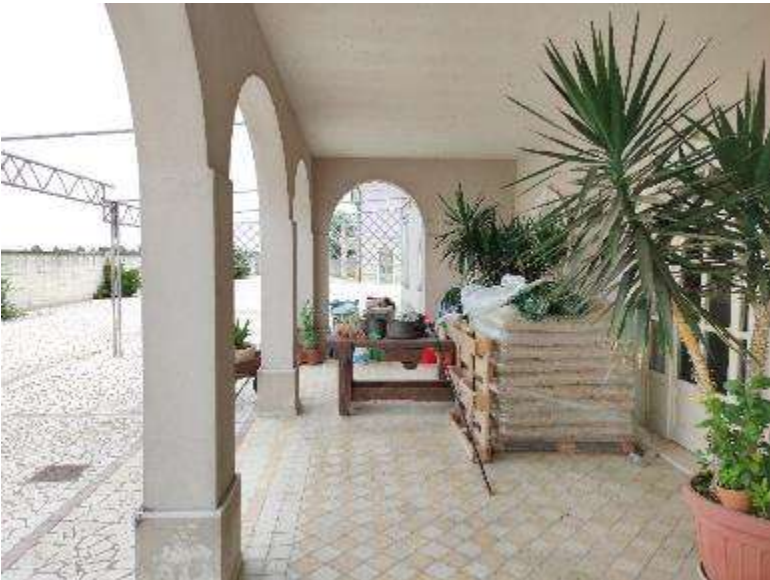
All. 9 – Particella 608 sub. 3 Portico lato Nord
