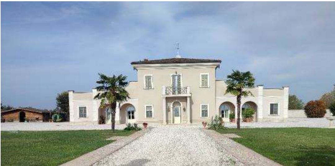
All. 3 – Particella 608 sub. 3 lato Sud
