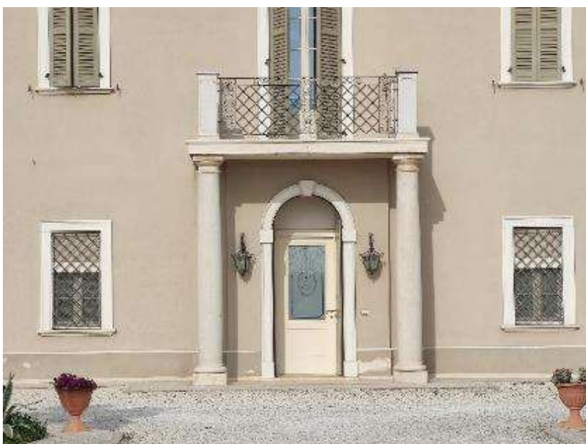
All. 7 – Particella 608 sub. 3 Ingresso lato Sud
