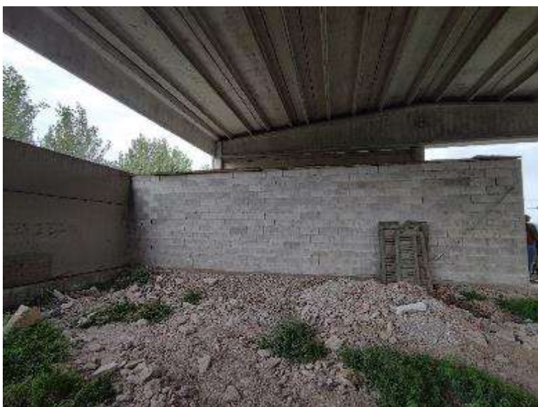
All. 21 – Particella 96 Interno
