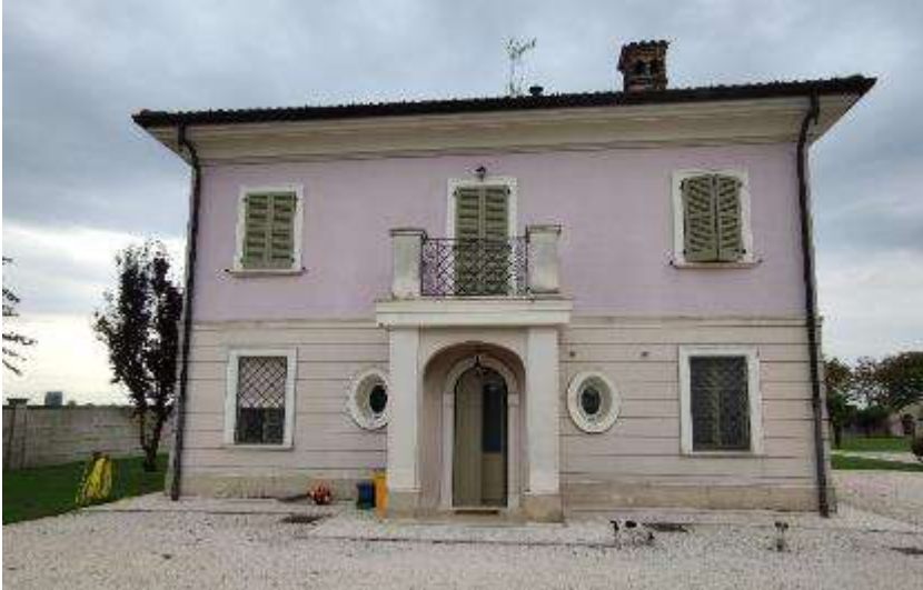
All. 11 – Particella 608 sub. 4 lato Nord
