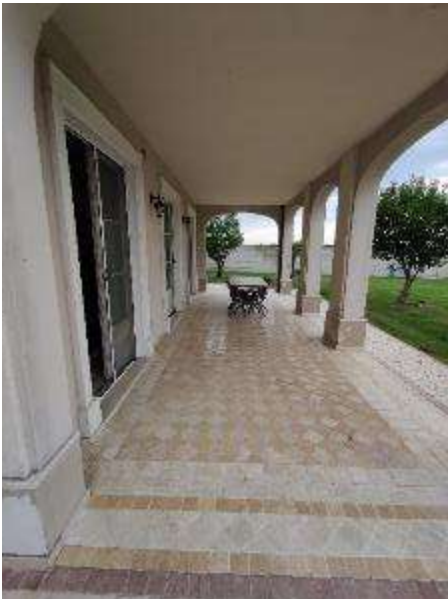
All. 13 – Portico Particella 608 sub. 4 lato Sud
