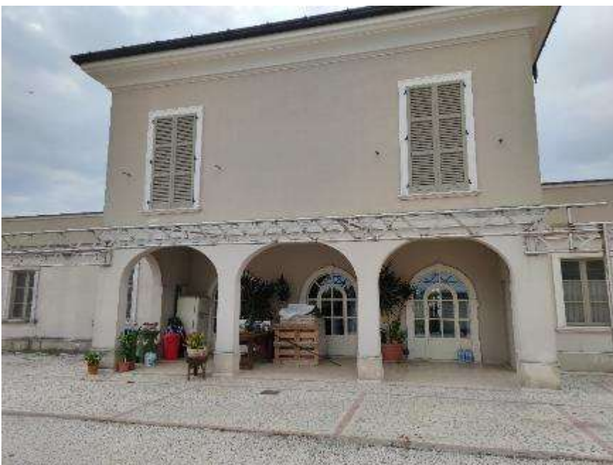
All. 4 – Particella 608 sub. 3 lato Nord
