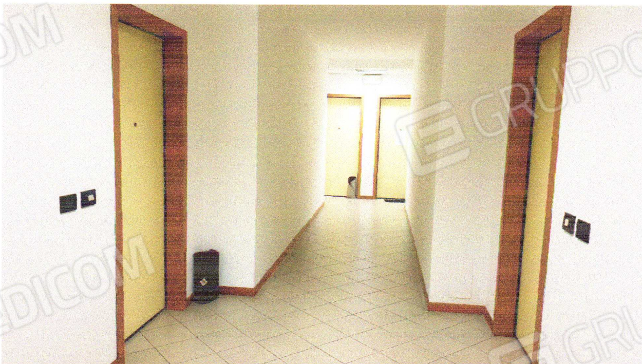
CORRIDOIO PIANO TERZO
