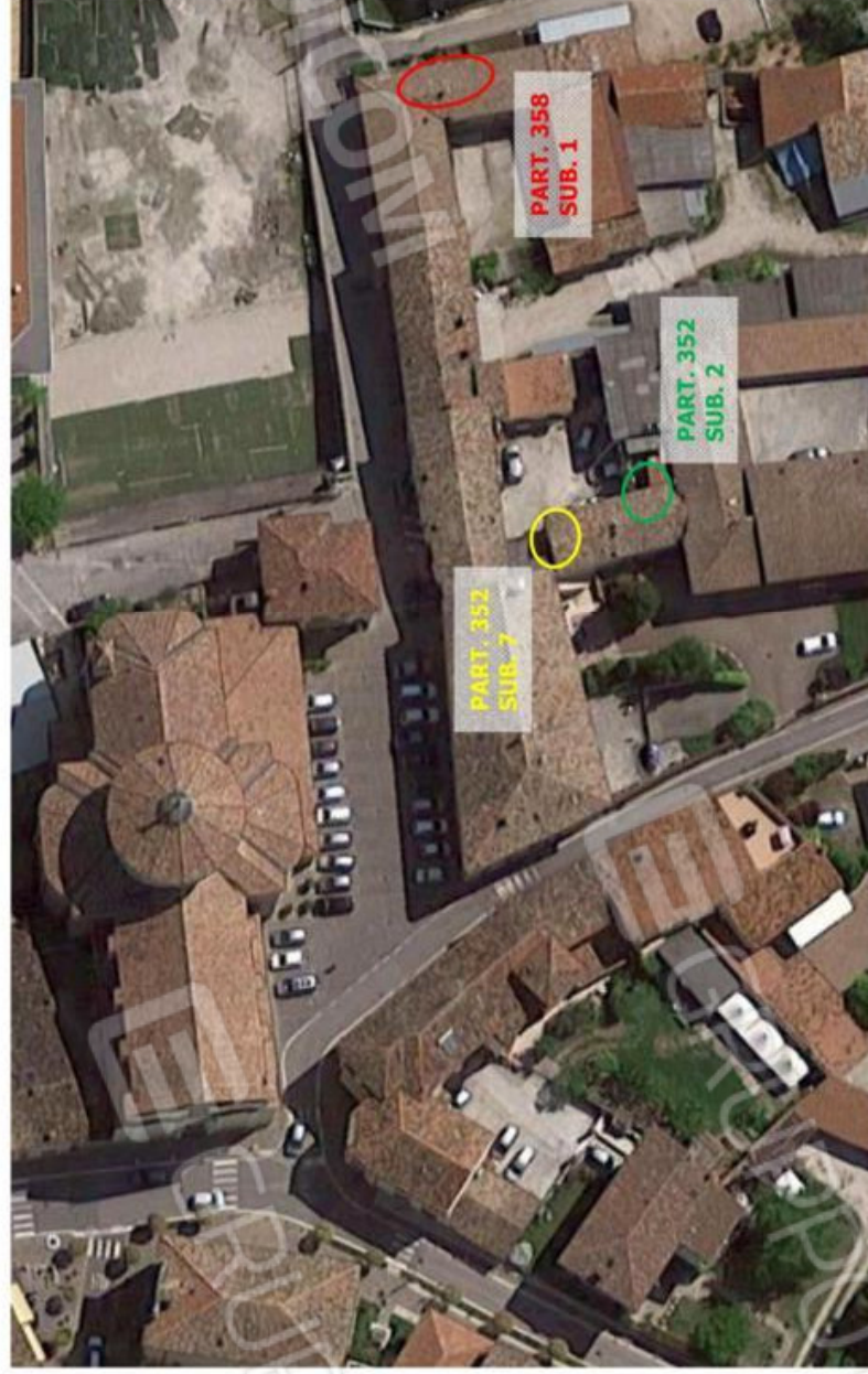
VISTA AEREA E POSIZIONE DEI TRE BENI STAGGITI
