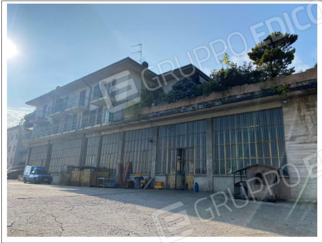
8) Fotografia che riprende la facciata esterna del FABBRICATO B ad uso produttivo con soprastante le altre 2 unità immobiliari oggetto di perizia (LOTTO 2 e LOTTO 3)
