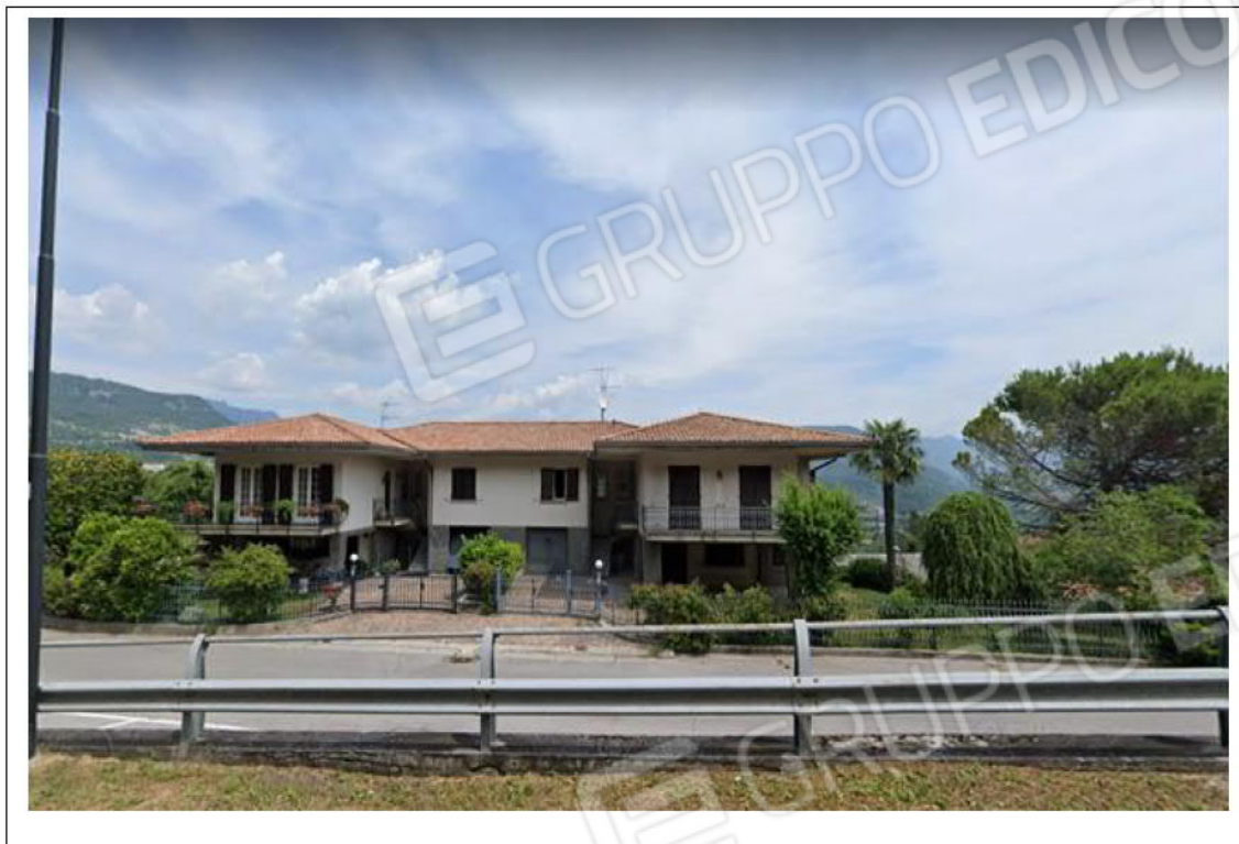
Fotografia che inquadra le 2 unità immobiliari ad uso residenziale denominate LOTTO 2 a dx e LOTTO 3 a sx.
