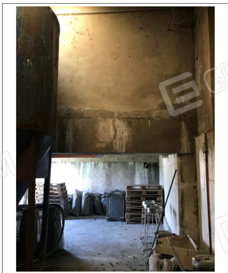
7) Fotografia che riprende i locali interni al piano interrato del FABBRICATO A
