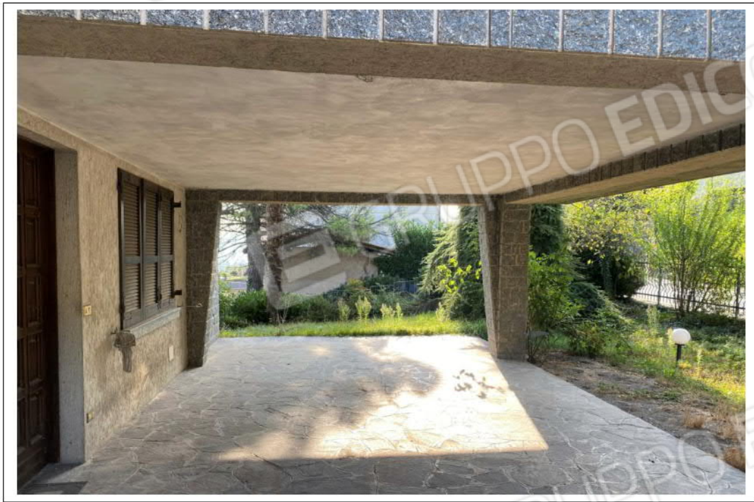
2) Fotografia che inquadra il portico di ingresso dell'unità abitativa del LOTTO 3.
