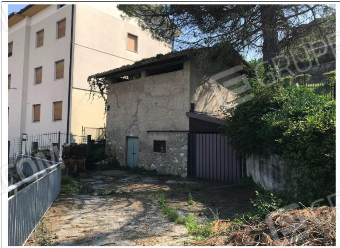
15) Fotografia che inquadra il FABBRICATO C con adiacente il box abusivo.
