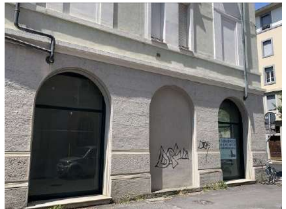
Vista del negozio da via Monte Grappa - prospetto est
