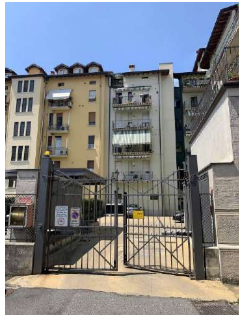
Accesso carraio al cortile pertinenziale del condominio
